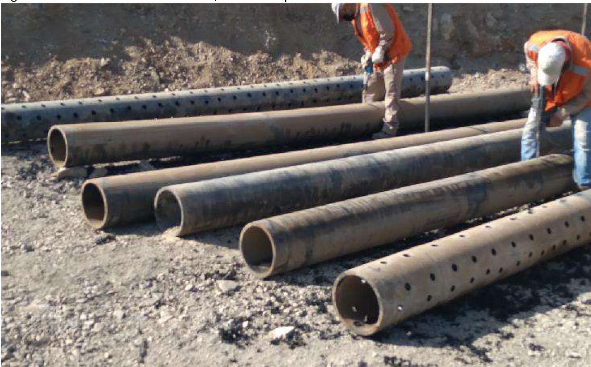
Figura N° 3. Perforación de Tubos HDPE, a fin de traspasar los Gases a las Chimeneas.
