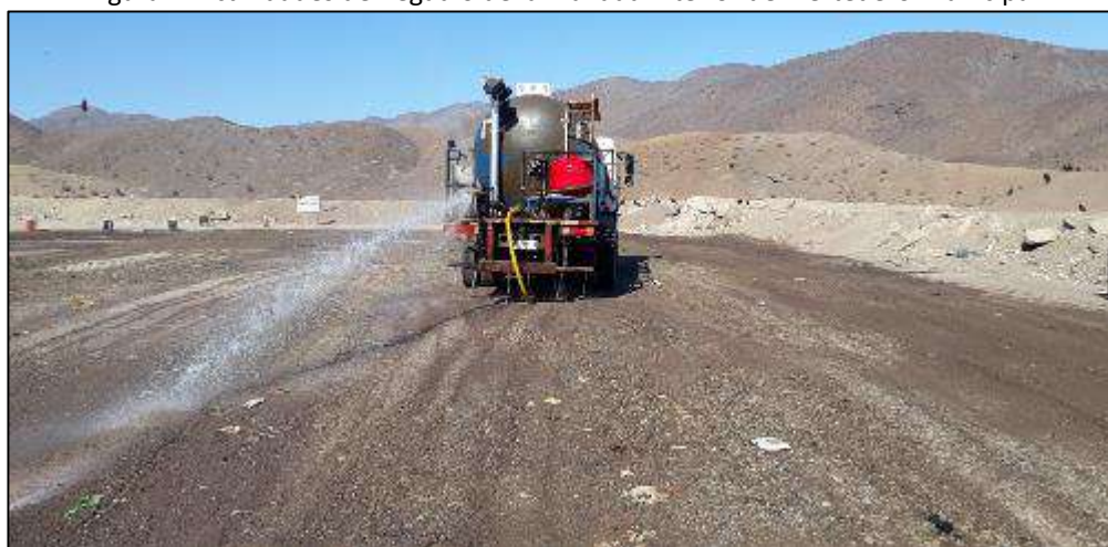
Figura 1. Actividades de Regadío de la Vialidad Interior del Vertedero Municipal
