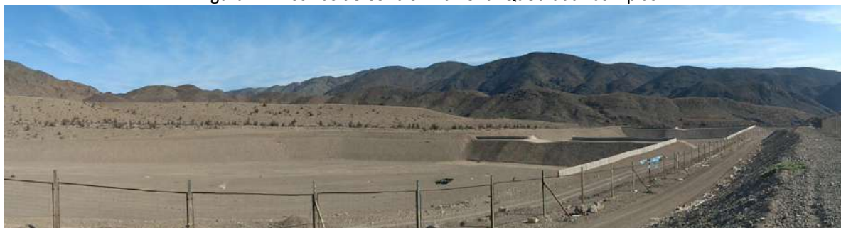
Figura N°. Piscinas de Control Aluvional Quebrada Las Tipias
