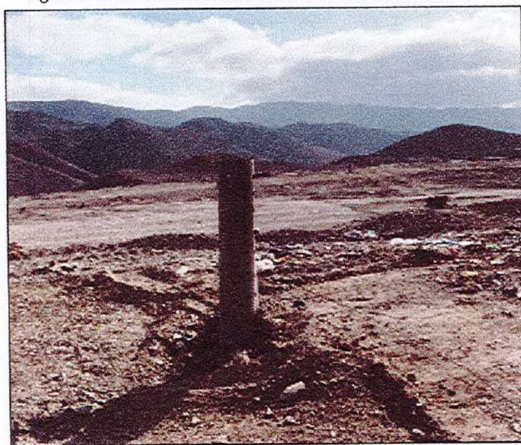
Figura N° 3.2.2. Chimenea de Evacuación de Gases. Celda N° 2
