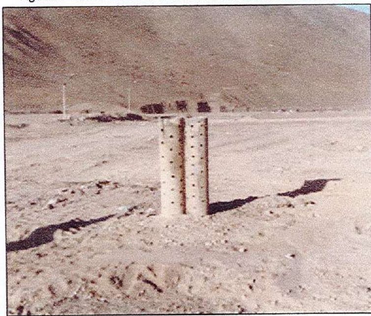
Figura N° 3.2.1. Chimenea de Evacuación de Gases. Celda N° 1
