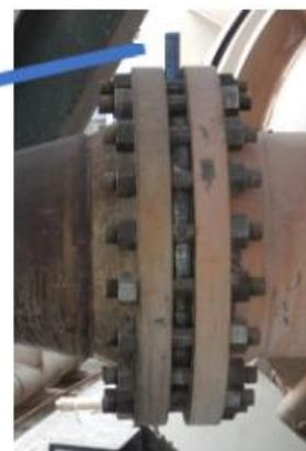
Figura 2: Bloqueo instalado
