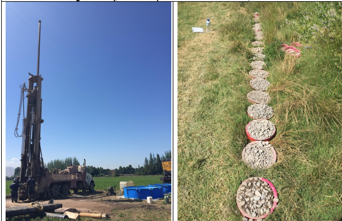
Fotografía 1: izq, labores de perforación en terreno. Der, muestras.
