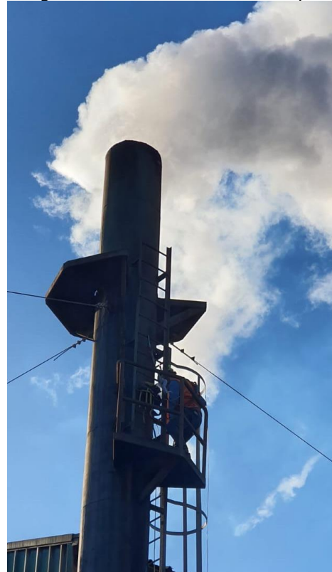
Imagen 2 – Chimenea extractor vapores de secadores
