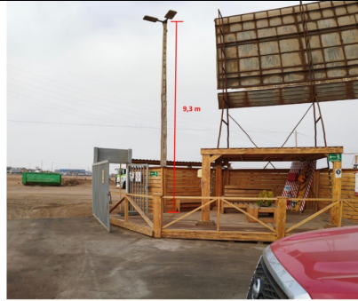
Instalacion de poste con luminaria Led en angulo gama 90°, con termoporizador el que permite optimizar los tiempos de encendido, disminuyendo la contaminacion luminica y comprometidos con el medio ambiente tambien un ahorro de energia.
