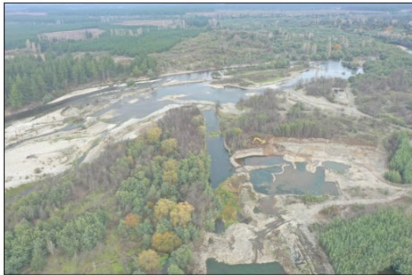
Figura N° 3: Vista de pozo de extracción de áridos
