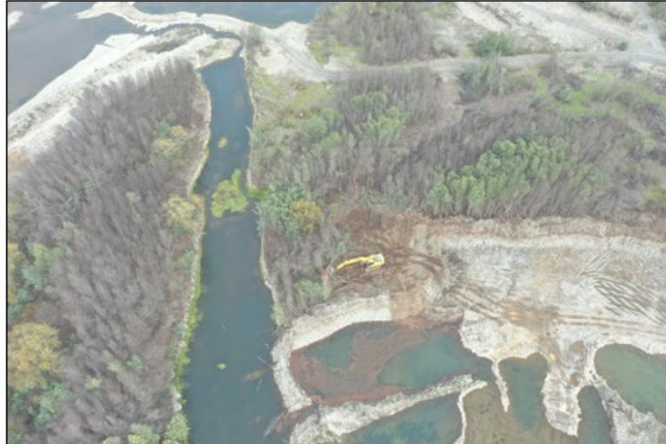
Figura N° 4: Vista de pozo de extracción de áridos
