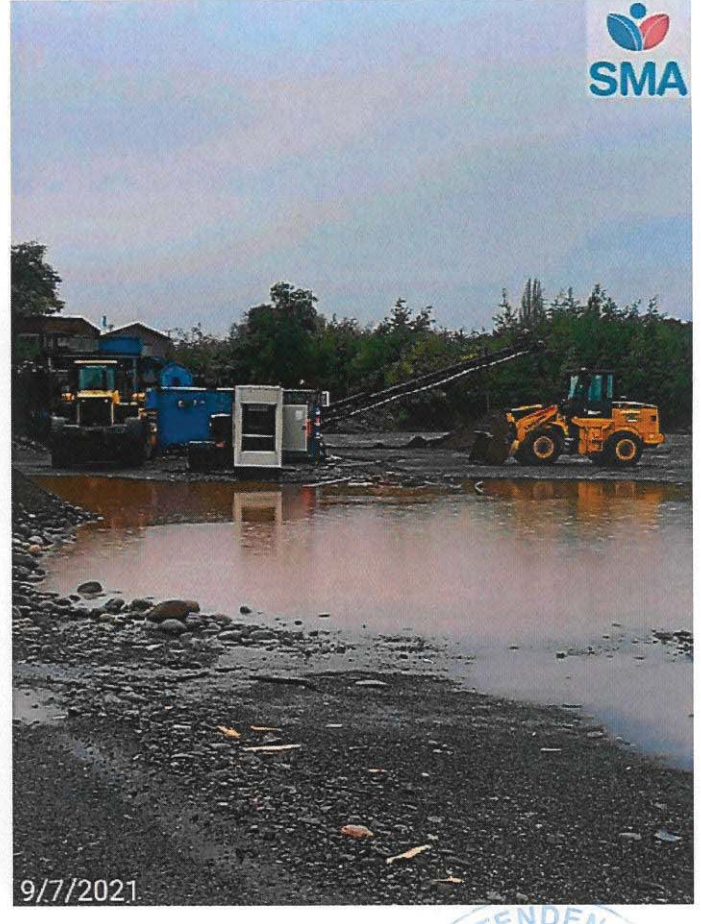
Foto N° 5 Planta chacadpora sector sur sin operación
