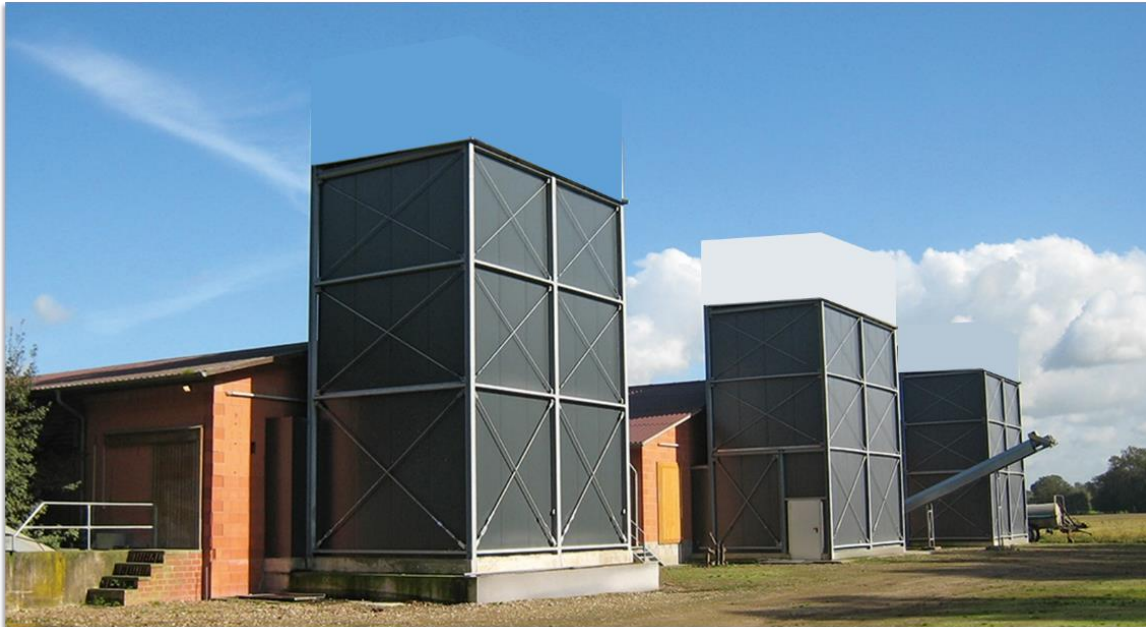
Figura 3. Imagen Referencial de las Casetas de Ventilación.
