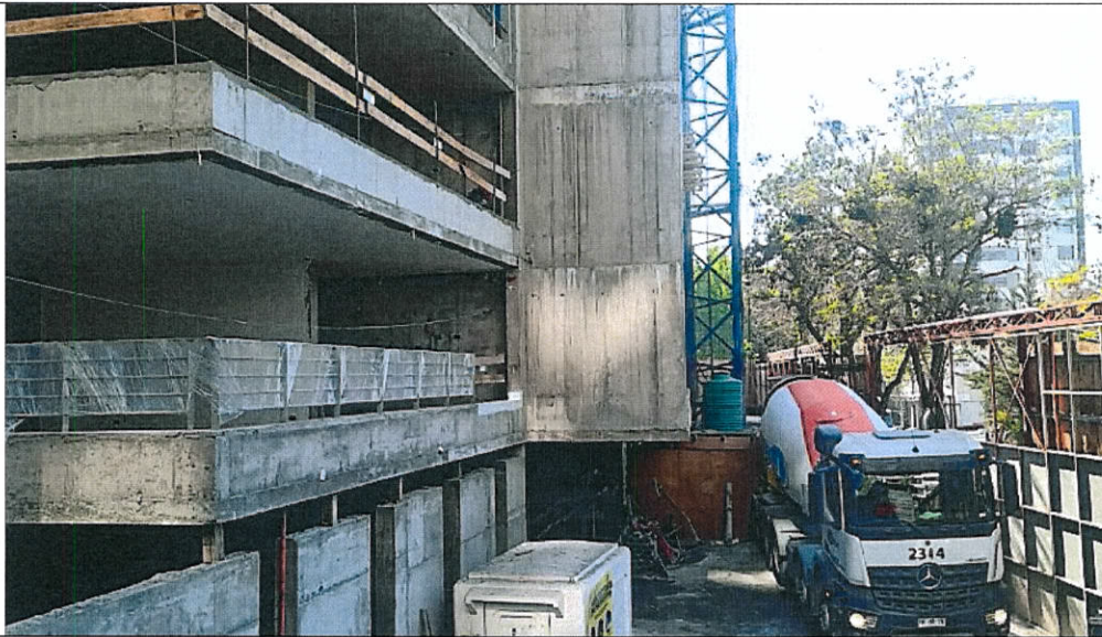
Fotografía 3: Encierro Acústico para Bomba de Hormigón
