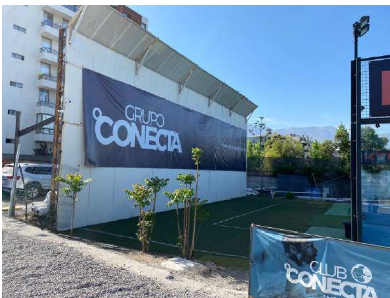
Fotografía N° 1, que da cuenta del aumento de la altura de la barrera acústica.
