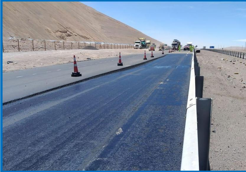
Imagen trabajos de recapado asfáltico realizados en 2019
