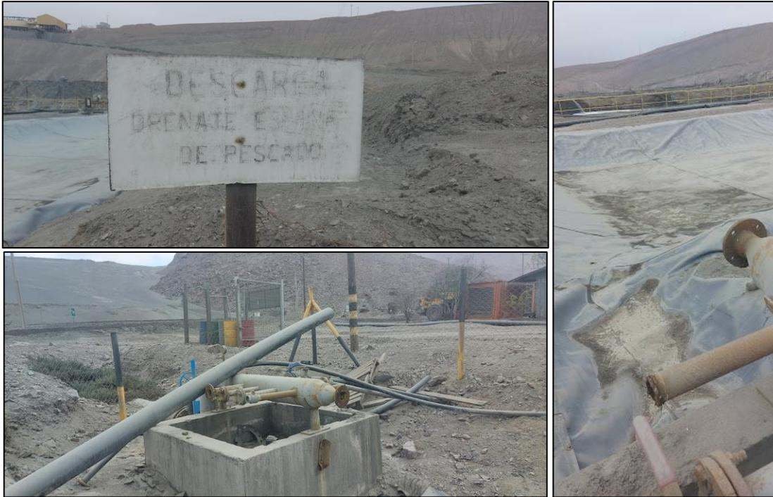
**Figura 3-4:** Fotografías de la salida del del sistema de drenaje del TREG. Se evidencia la condición de sequedad en el sistema de recolección.
