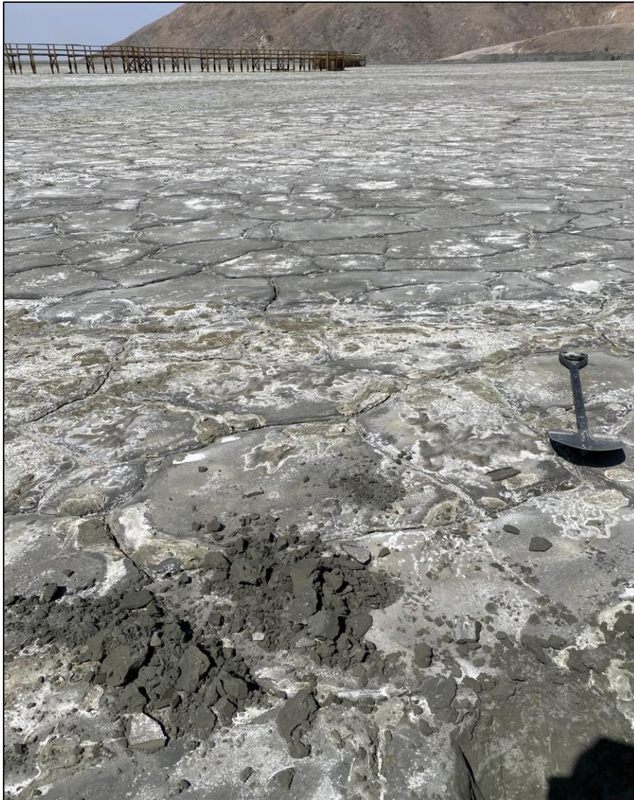
**Figura 3-3:** Fotografía de la cubeta del TREG, en el sector de la cola del tranque, donde antiguamente se acumulaba la laguna de aguas claras. Se evidencia la condición de alta evaporación en los relaves superficiales.
