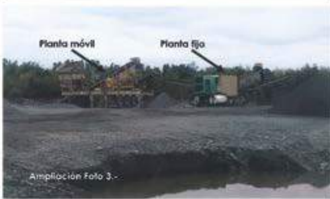
Foto 3.- Vista desde ingreso a terreno.
