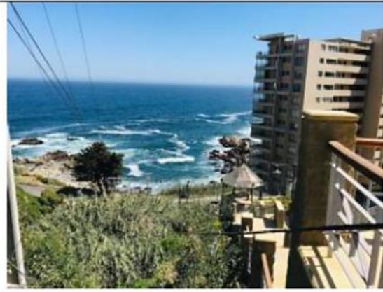
Vista desde Calle Cornisa, hacia escalera construida.
