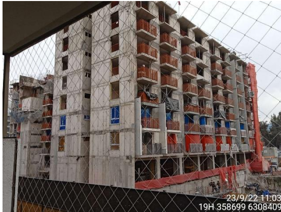
Vista general de la obra
