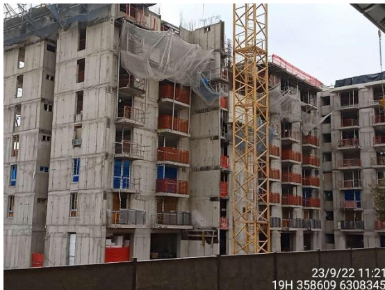
Vista general de la obra
