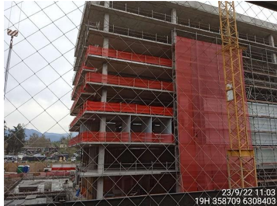
Vista general de la obra
