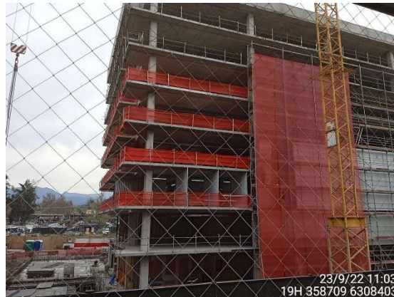
Vista general de la obra
