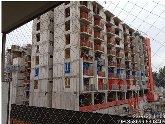
Vista general de la obra
