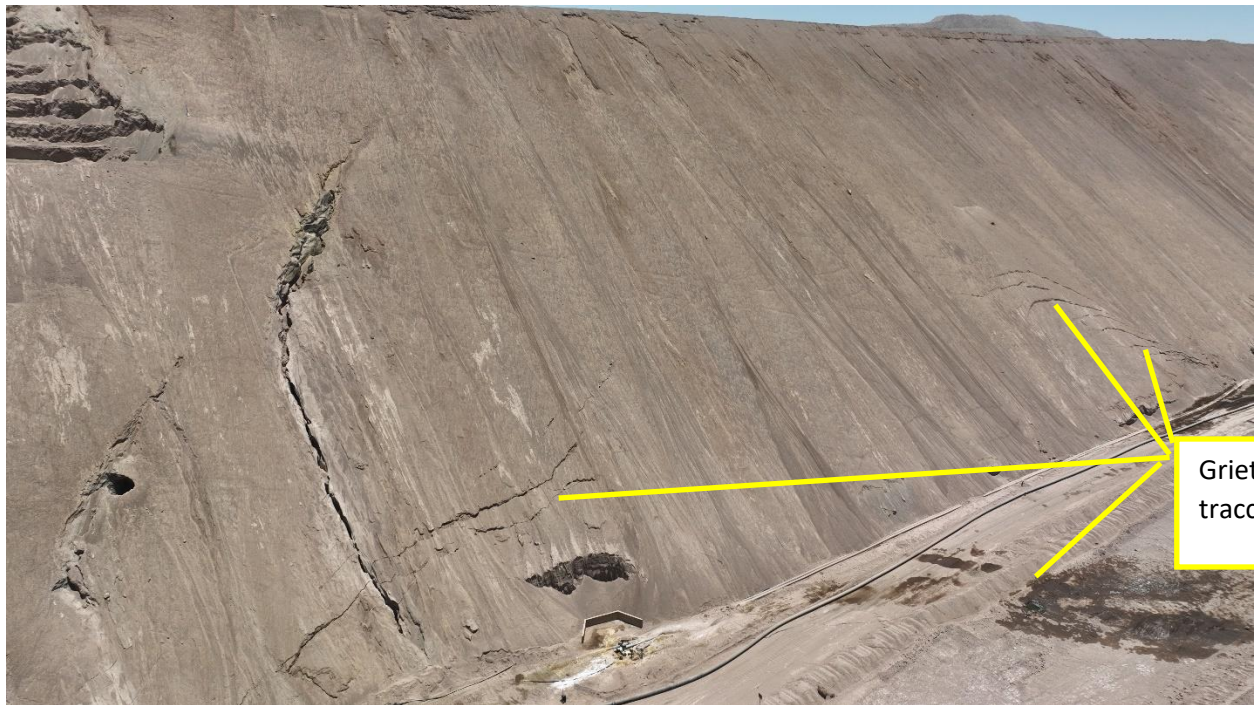
Fotografía N°14: vista aérea sector del talud Mantos Copper km 1404,600 del (17/01/2023)
