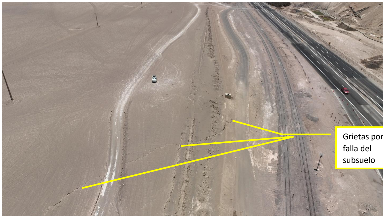
Fotografía N°16 vista aérea sector del talud Mantos Cooper km 1406,600 lado sur carretera zona FACB fecha 17/01/2023
