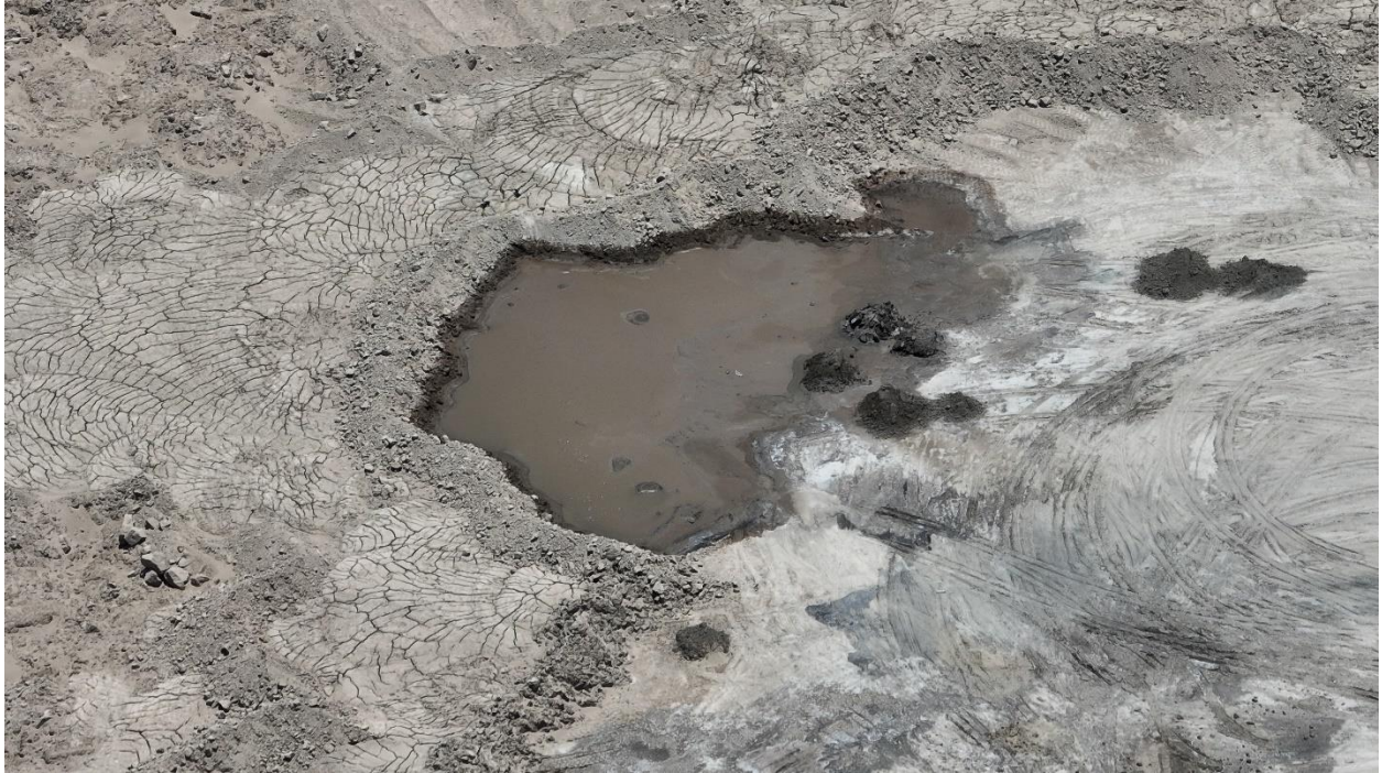
Fotografía 10: vista aérea afloramiento de agua en el coronamiento talud Mantos Cooper del (17/01/2023)
