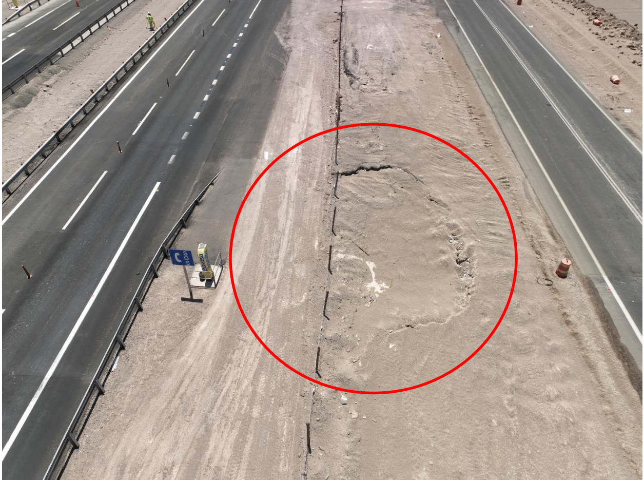
Fotografía N°11: vista aérea km 1407.200 lado derecho del (17/01/2023)
