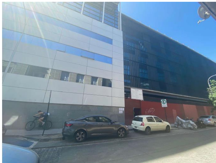
Figura 7 Muro cortina que colinda con calle Jofré
