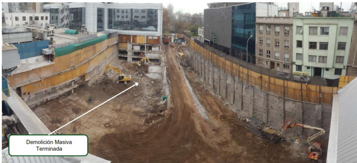
Figura 6 Fotografía de demolición terminada
