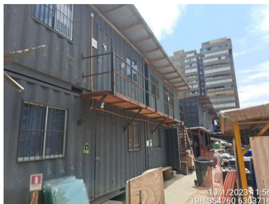
Vista general instalación de faenas de torre 2
