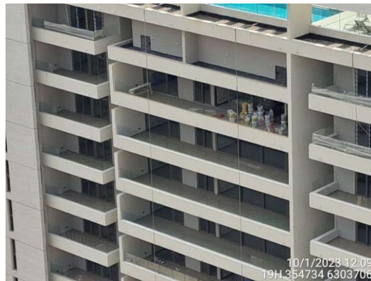
Trabajos en fachada norte de torre 1
