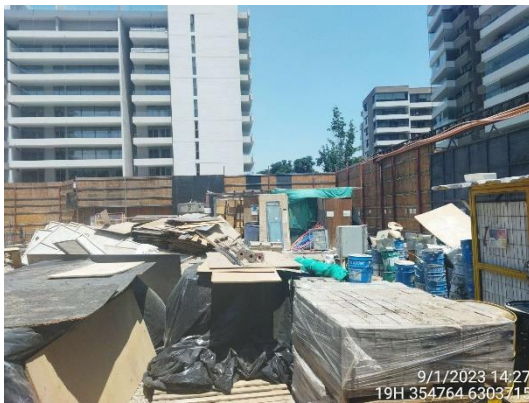
Vista general de patio de acopio de Unidad Inspeccionada
