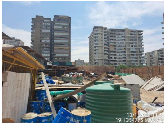
Vista general patio de acopio de Unidad Inspeccionada
