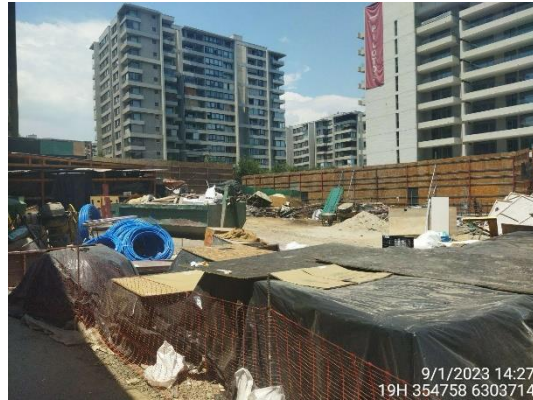
Vista general de patio de acopio de Unidad Inspeccionada
