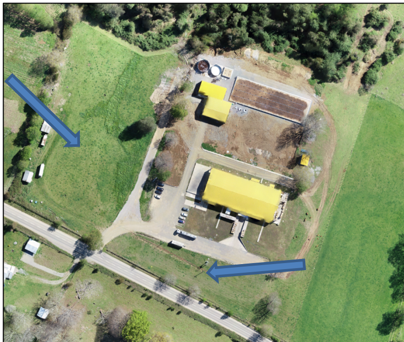
Registro Fotográfico Aéreo N°1: Área de descarga RILes tratados, Sector 1 y 2.
