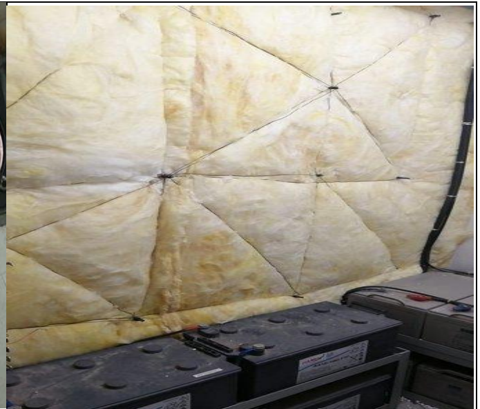
Vista trabajo terminado
