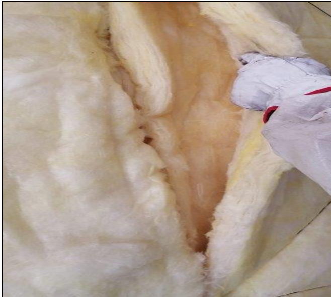
Doble lana mineral instalada
