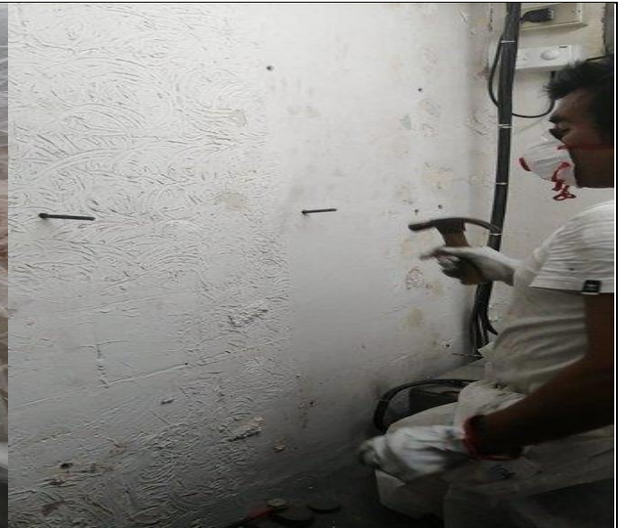
Instalación de fierro de 6mm
