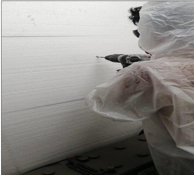
Perforando el muro
