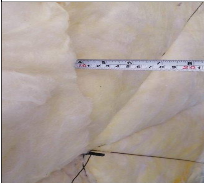
Espesor logrado de lana mineral,10cm
