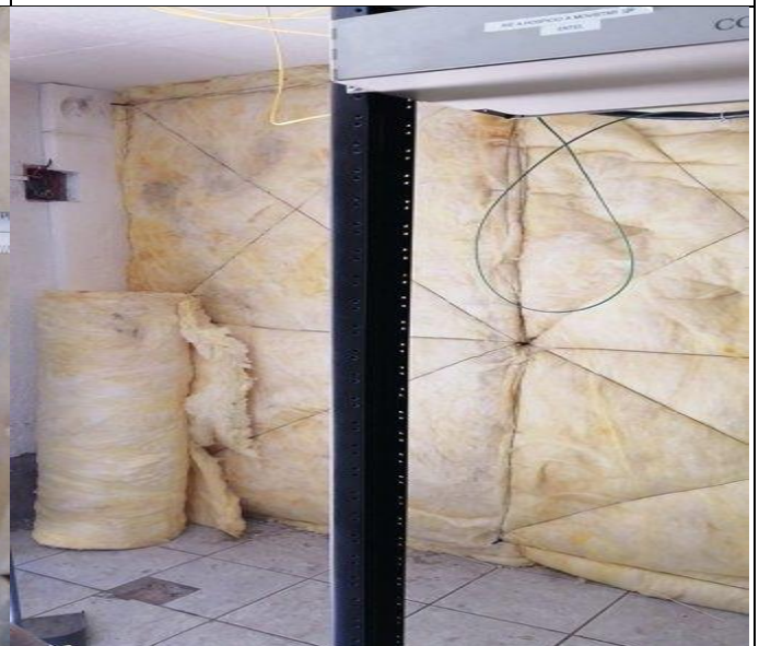
Vista trabajo terminado
