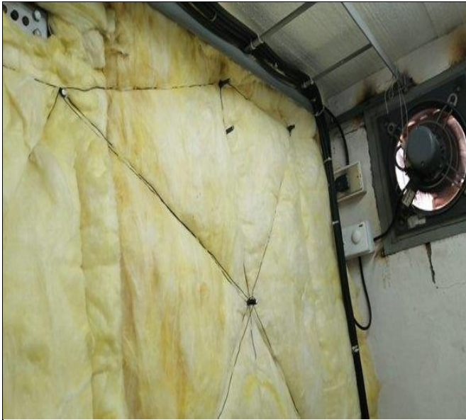
Vista trabajo terminado
