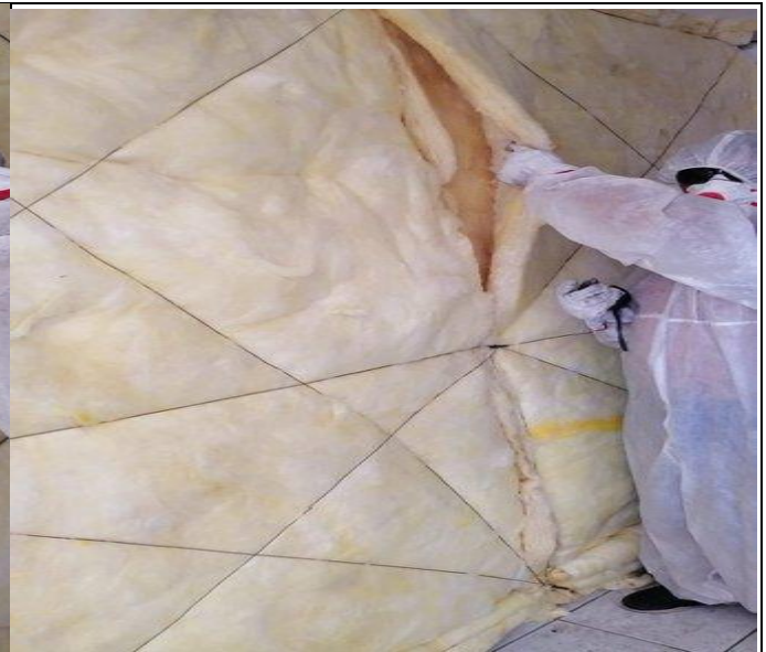
Lana mineral afianzada al muro con alambre
