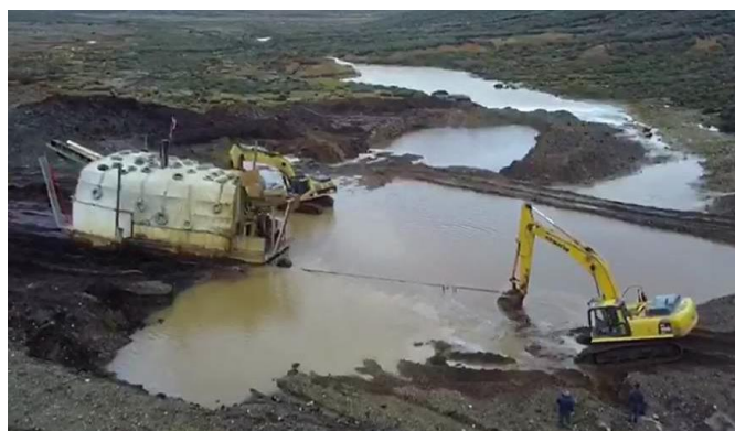
(Foto 10: Vista de la planta de procesamiento siendo ingresada al reservorio)
