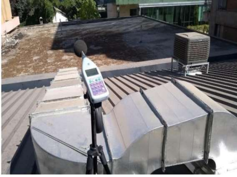
Aislación y modificación de ducto de extracción área cardio
