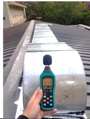
Aislación y modificación de ducto de extracción área cardio
