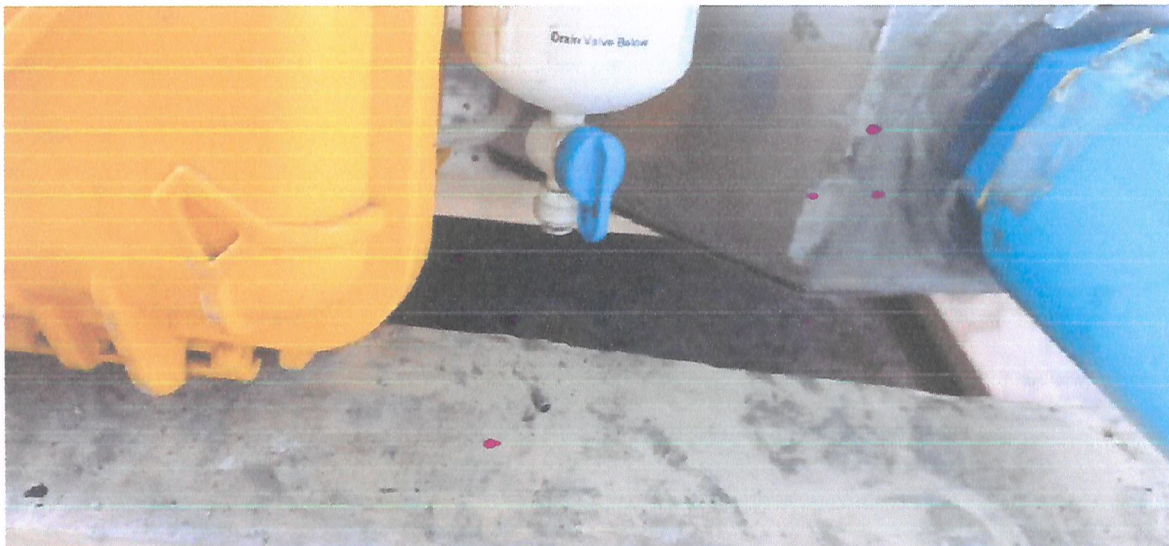
Ilustración 8 : Válvula de despiche Sensores H2S
