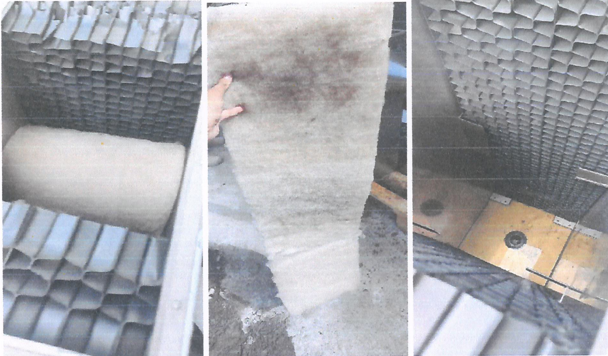
Ilustración 9: Revisión de equipo corta gota y filtro geotextil
