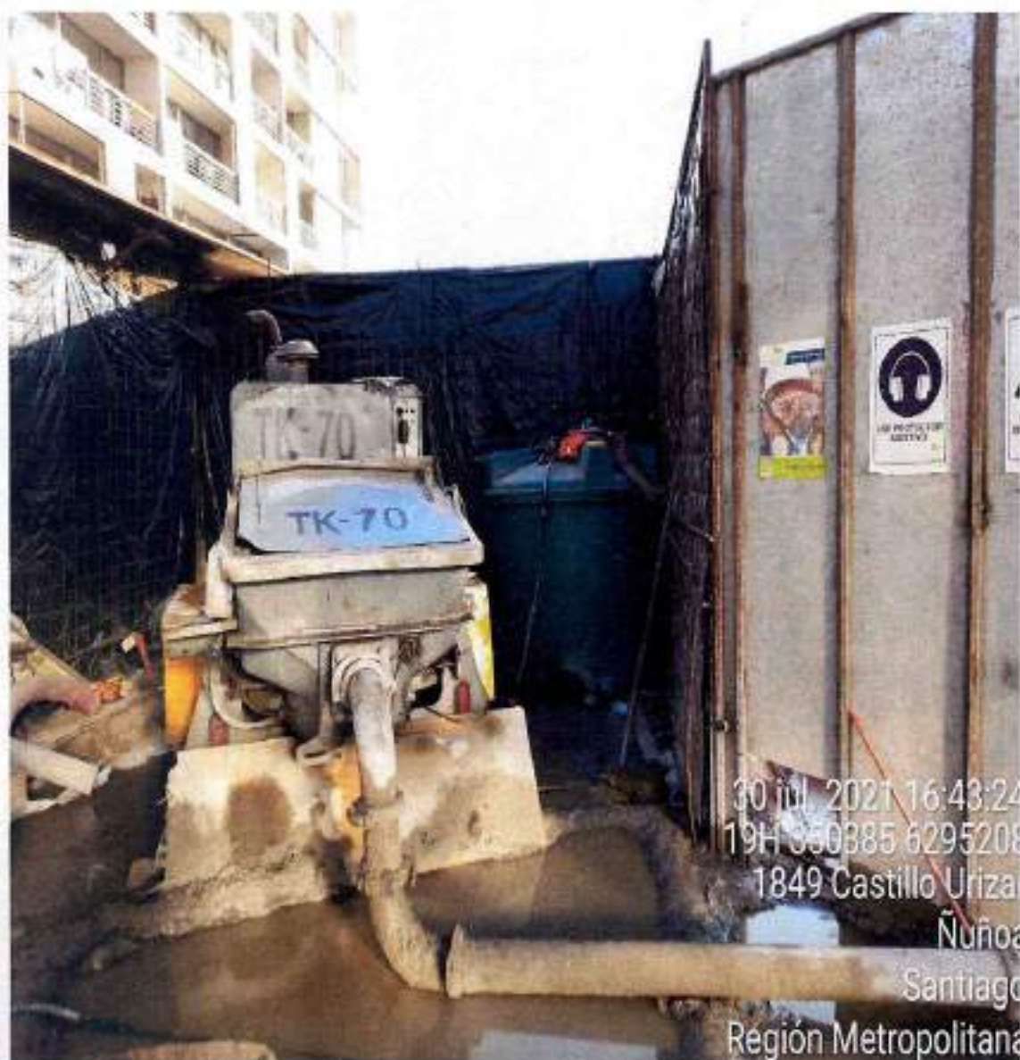
Instalación protección acústica sector bomba estacionaria para faena de hormigonado
