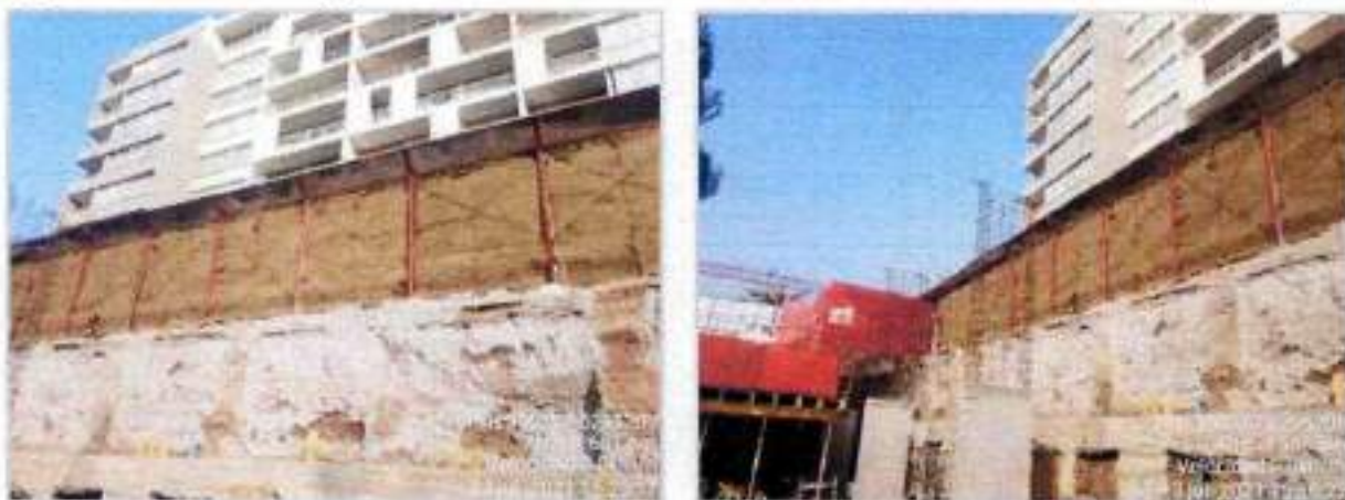
Figura 5: Barrera de 3,5 [m] para formar encerramiento en generador diesel.
