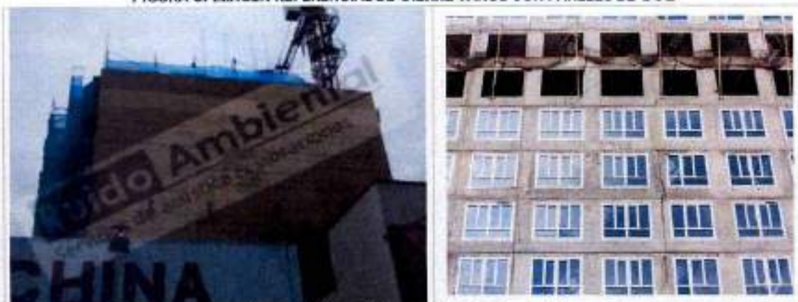
FIGURA 6: IMAGEN REFERENCIAL DE CIERRE VANOS CON PANELES DE OSB
