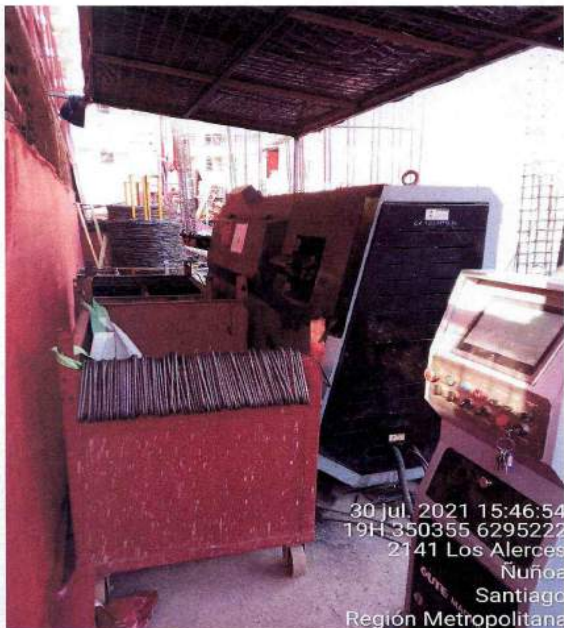
Se automatiza parte del proceso de corte y doblado mitigando el 50% de las emisiones de esta faena
