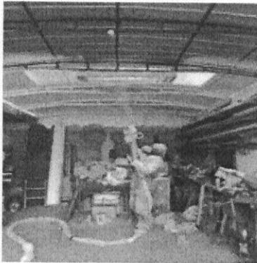
Aplicación de Poliuretano expandido en cubierta interior de techumbre de taller.
