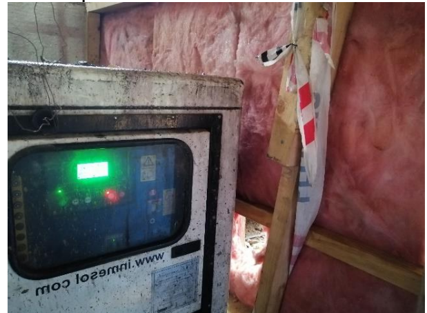
Encierro acústico Generador piso 1
