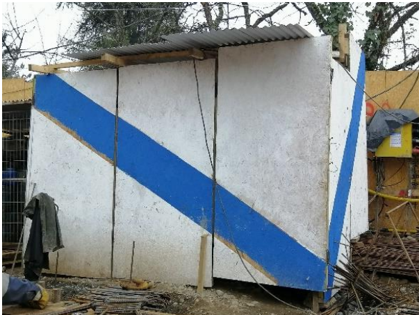
Encierro acústico Generador piso 1
