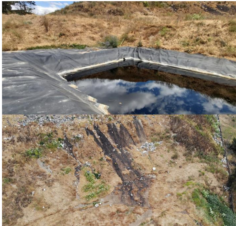
Figura 12: Piscina Lixiviados. Fuente: DSS.
