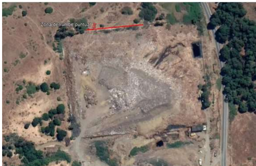
Fuente: Imagen Google earth que muestra sector acotado de deslizamiento
