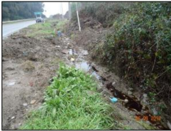
Figura N°9: canal de aguas lluvias paralelo al Vertedero Angol con contacto de residuos y lixiviados.
