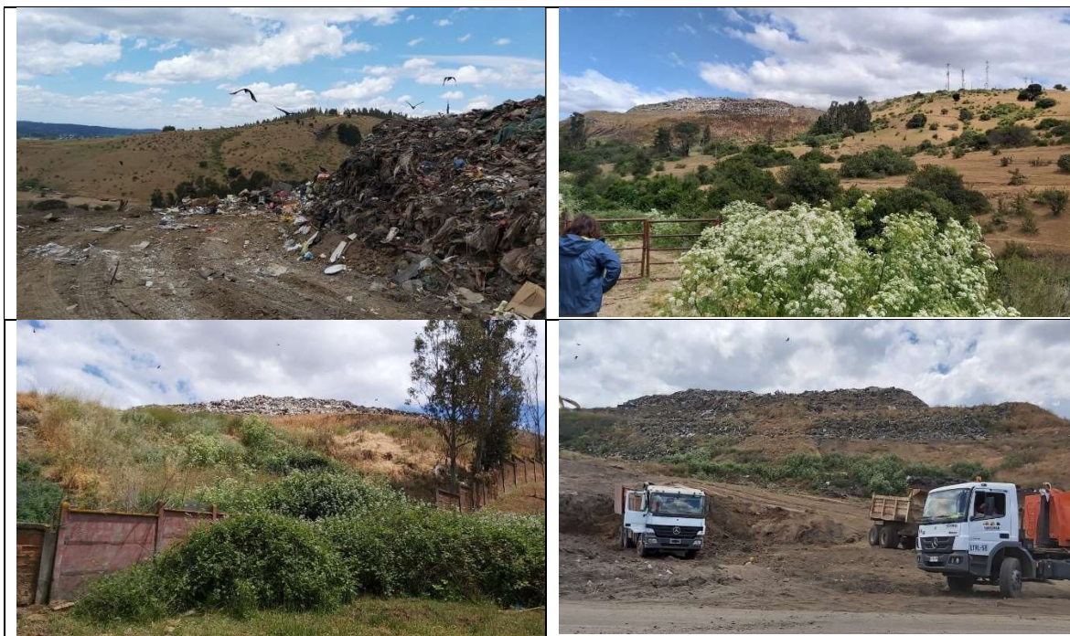
Fuente: set fotográfico condición actual del Vertedero
