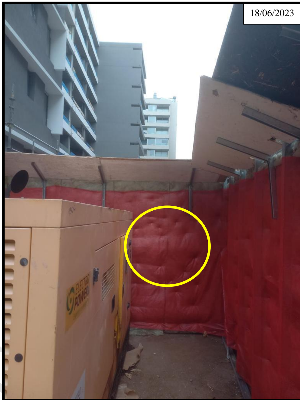
Instalación de Lana Mineral en grupo generador N°2)
