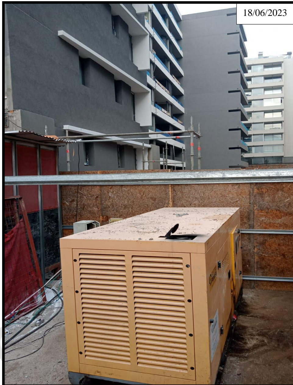
(Instalación de Lana Mineral en grupo generador N°2)
