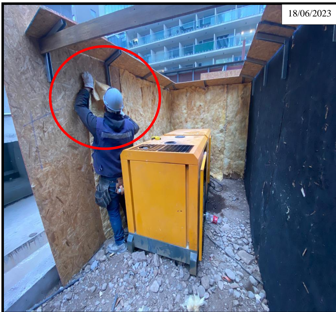
(Instalación de Lana Mineral en grupo generador N°1)
