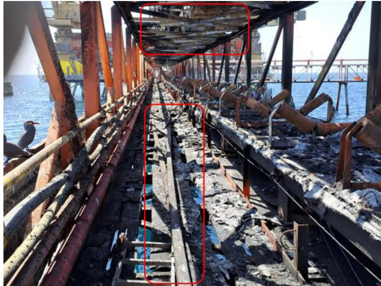
Figura 7 Estado de la galería de acceso y cinta transportadora posterior al incendio
