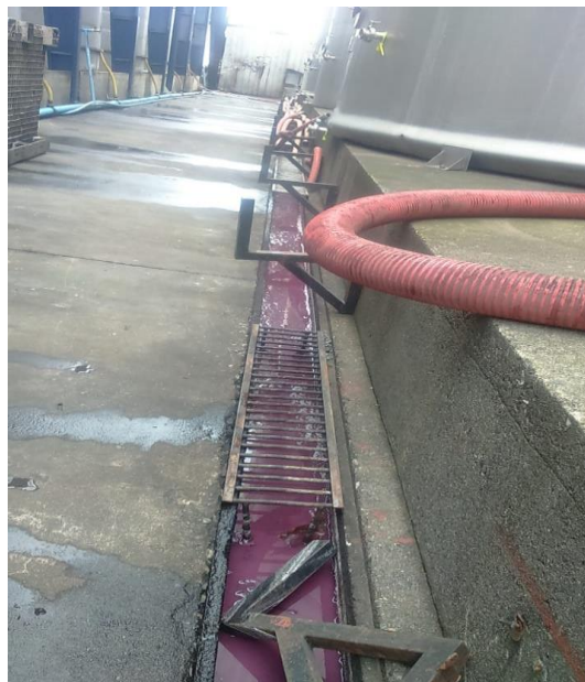
Imagen 4: Ducto que descarga a canal, con tapón provisorio.
