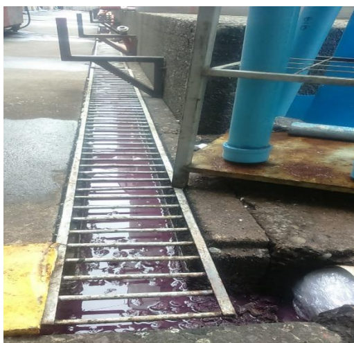
Imagen 3: Descarga de Riles Sala de vendimia.
