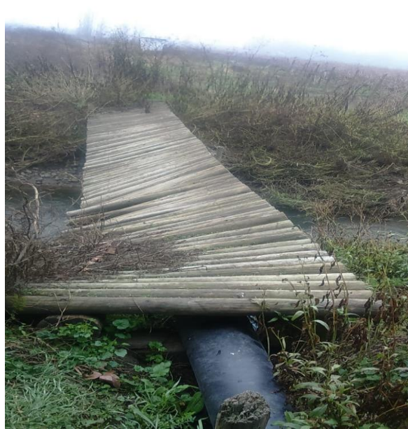
Imagen 16: Acceso a las piscinas de decantación en mal estado.
