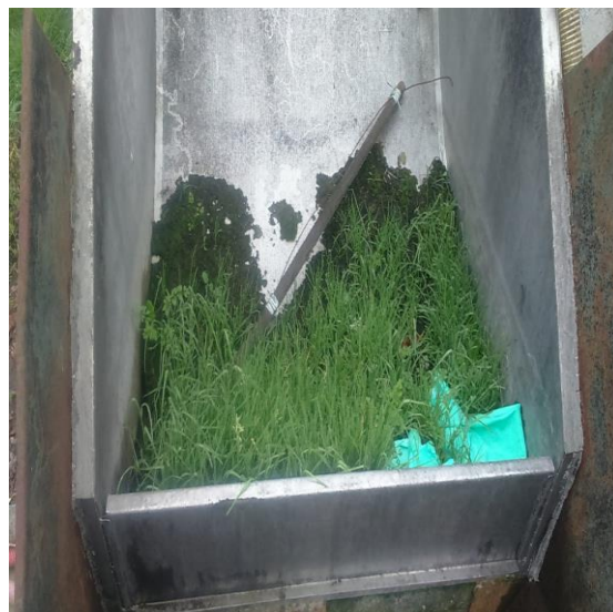
Imagen 16: Acceso a las piscinas de decantación en mal estado.
