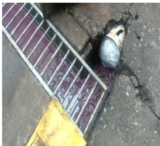
Imagen 4: Ducto que descarga a canal, con tapón provisorio.
