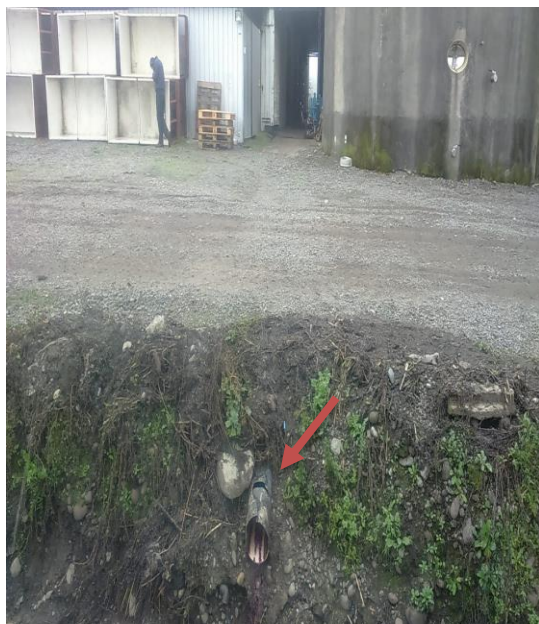
Imagen 7: Inicio del recorrido de RILES desde el tubo de descarga.
