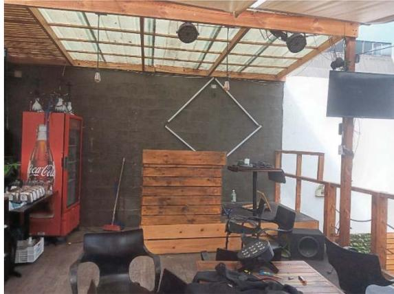
ESTRUCTURA DEL LOCAL: La estructura de muros evidenciada en el local arroja una altura de 2.8 metros, cuyo muro sector sur es de material de construcción de cemento o bloques utilizando como corta fuegos; el muro sector este, es de material ligero y estructura de metal recubierto con internit de 3 mm. Estas características de constructividad provocan que las emisiones sonoras escapen de forma más fácil hacia los lados sur y poniente de cada vecino, generando así los ruidos molestos.
