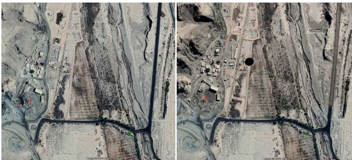
Figura 2-3: Vista Condición Pre y Post Socavón
