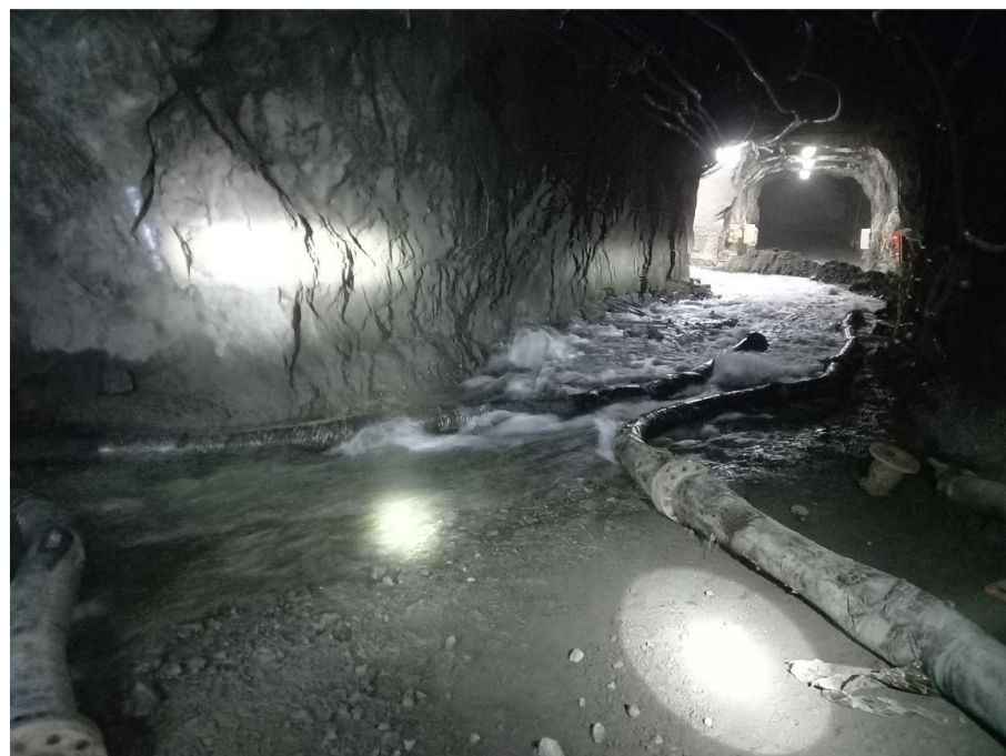
Figura 2-6: Esguerrimiento de Agua Interior Mina Subterránea
