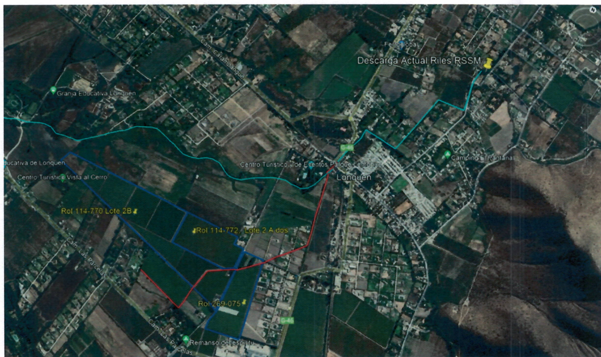
Imagen 2. Detalle descarga Riles y predios PTAL
