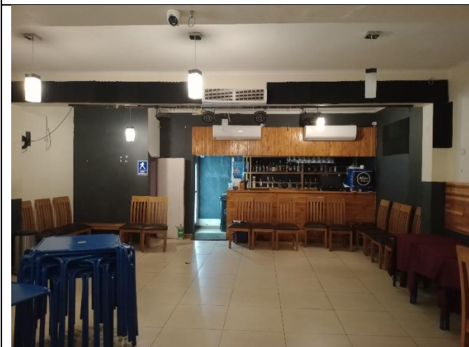
Vista al fondo del salón de igual manera el muro del fondo tiene doble vulcanita por cada lado o sea son 4 planchas de vulcanita acústica e internamente tiene vidrio y lana acústica
