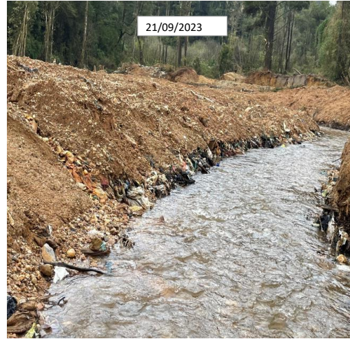
Escorrimento de basura a orillas del Mosco la cual debio ser retirada solo se tapo con tierra contaminada con lixiviados
