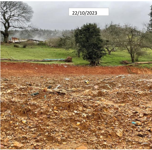
Tierra contaminada con lixivados para tapar basura escurrida la cual debe ser retirada
