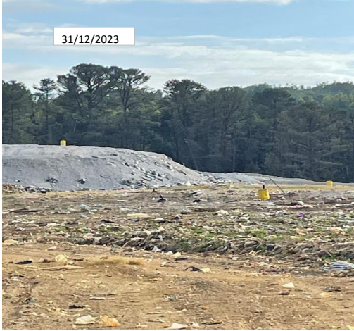
Nuevo frente de trabajo presentado por la parte frontal
