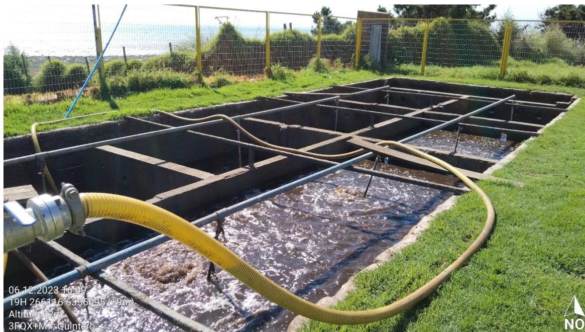
Imagen 12. Piscina de equalización (Riles) Fuente: Fotografía del 06.12.2023
