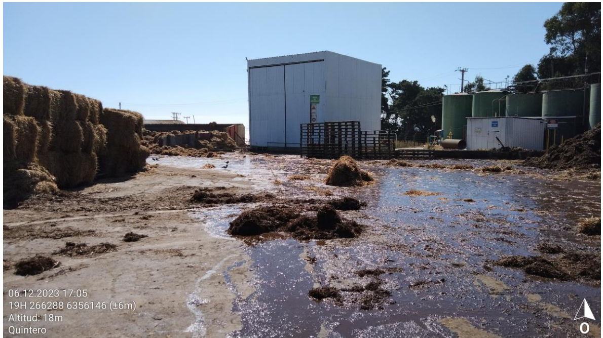
Imagen 4. Esguerrimiento de las aguas por pendiente hacia piscina purín
