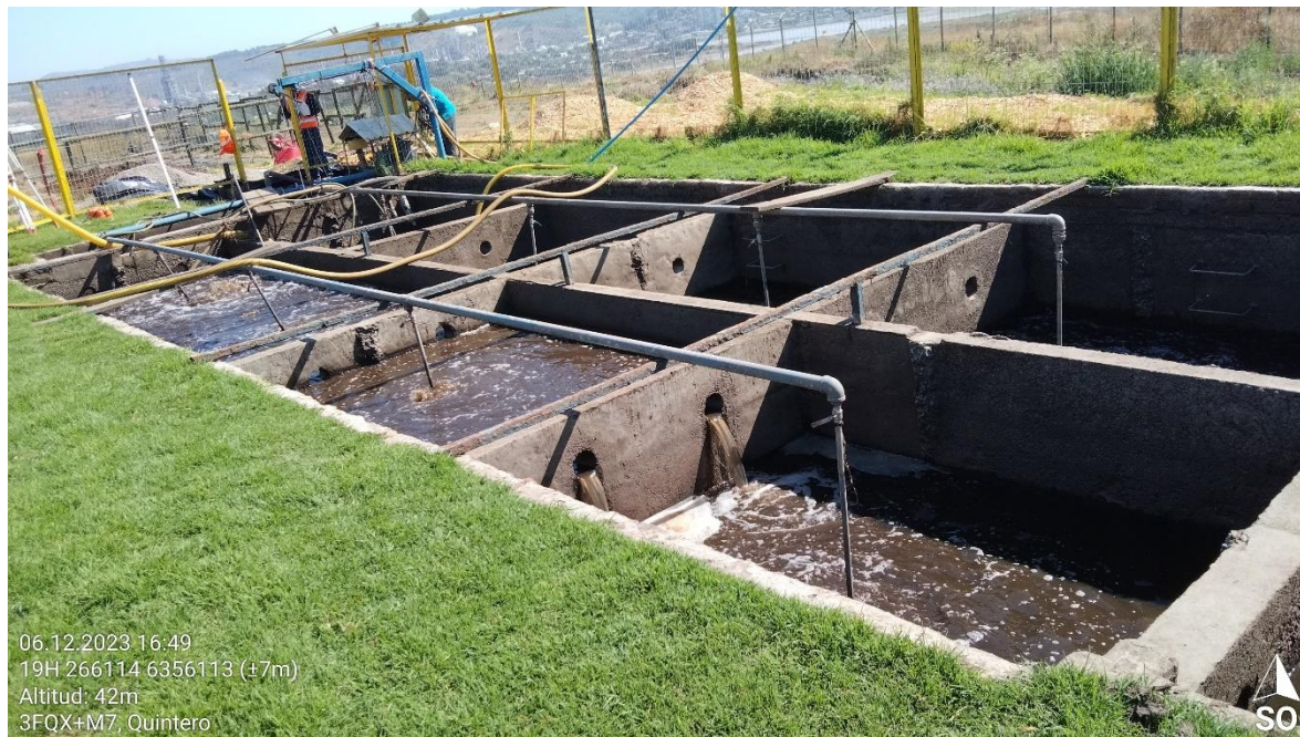
Imagen 11. Piscina de equalización (Riles) Fuente: Fotografía del 06.12.2023
