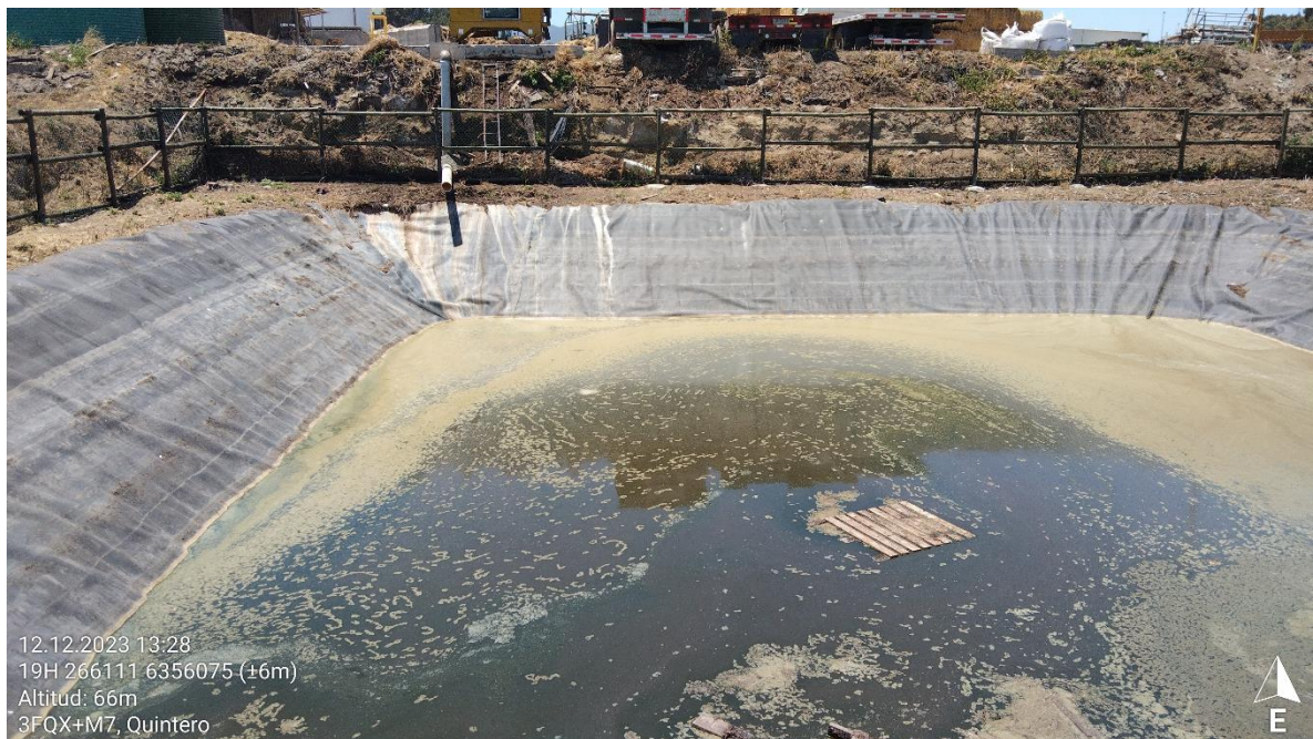
Imagen 8. Estado actual piscina aguas lluvias Fuente: Fotografía del 12.12.2023
