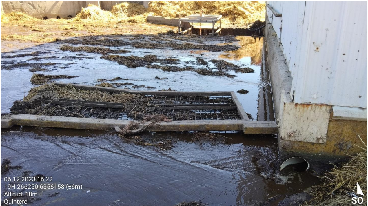
Imagen 1. Ingreso de aguas a piscina purín durante el proceso
