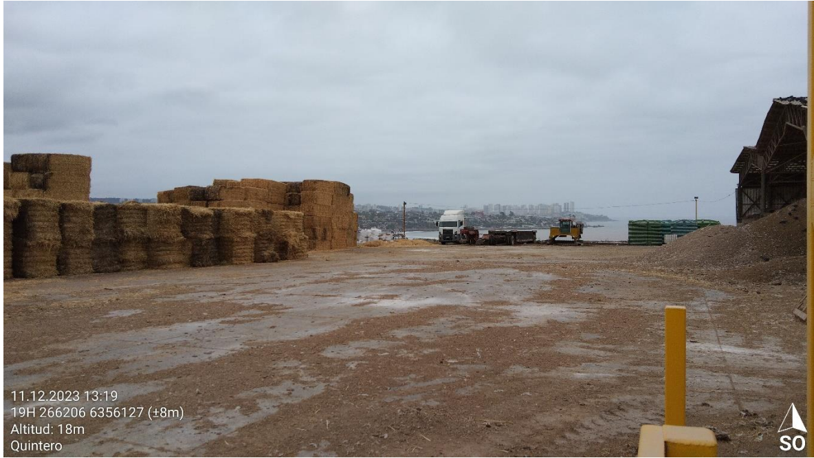
Imagen 6. Losa de acopio materias primas durante procesos Fuente: Fotografía del 11.12.2023
