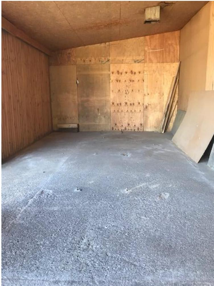
Se aprecian los anclajes antiguos y ducto de extracción de material.
