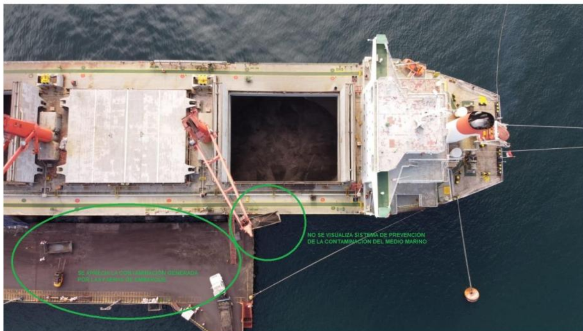
Lectura izquierda: "Se aprecia la contaminación generada por las faenas de embarque."; Lectura derecha: "No se visualiza sistema de prevención de la contaminación del medio marino."
