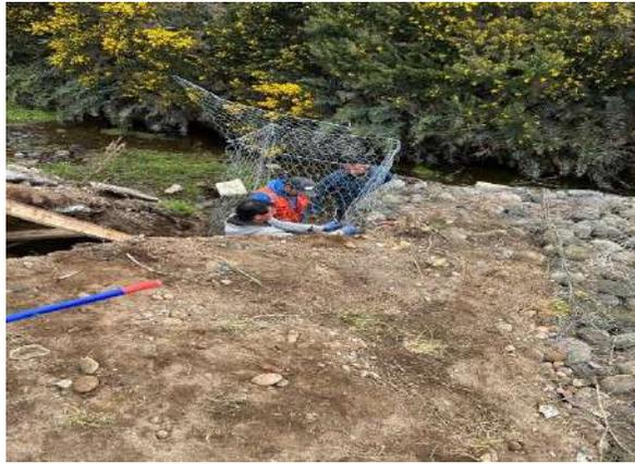
Instalación de malla de gaviones faltantes en ala derecha de la descarga muro boca N°1.
