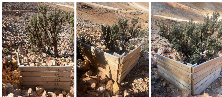
Figura 31 Ejemplo instalación de protección contra material erosivo del 6 de mayo de 2024.
