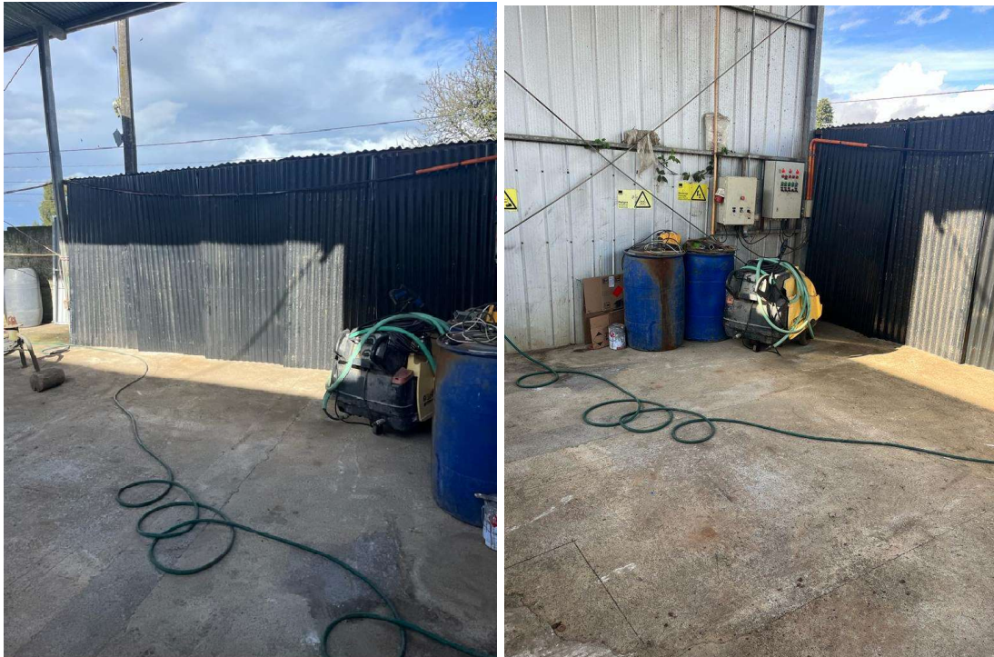
Figura 11. Galpón de tratamiento sin equipos.
