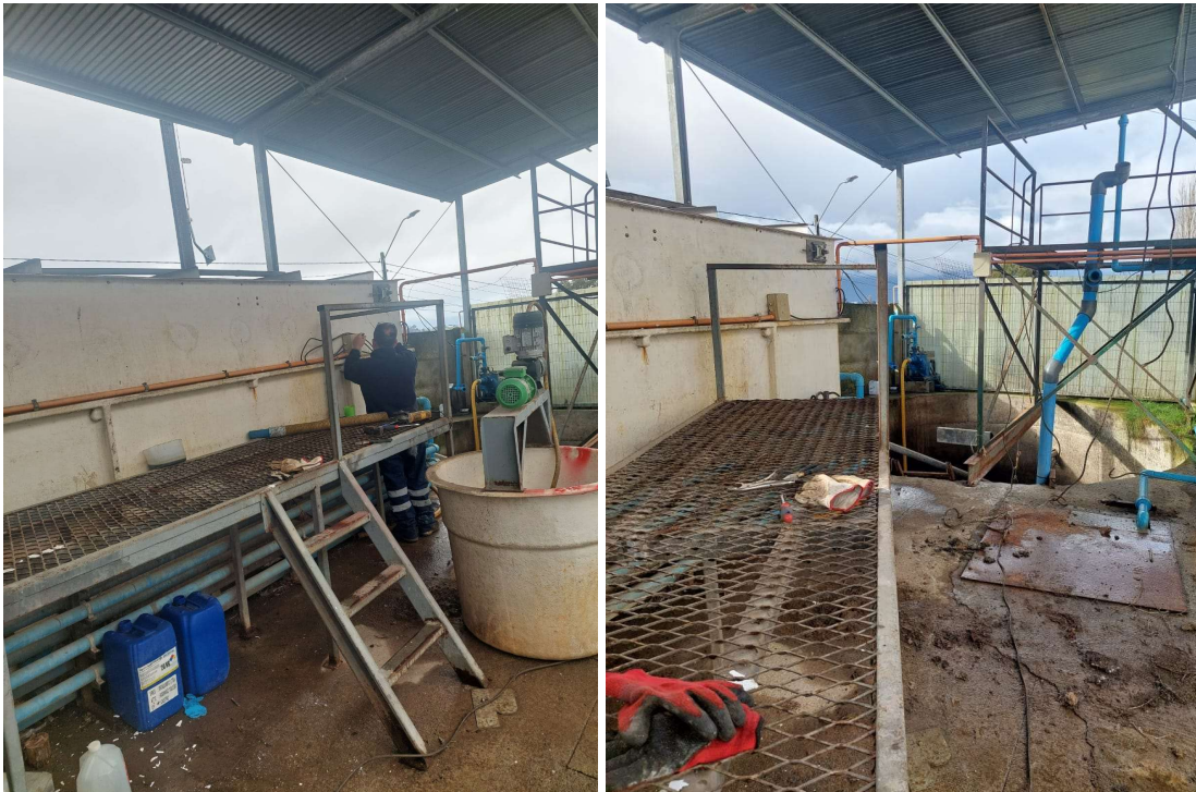
Figura 9. Desarme estanque clarificador, serpentín y retiro estanque polímero.
