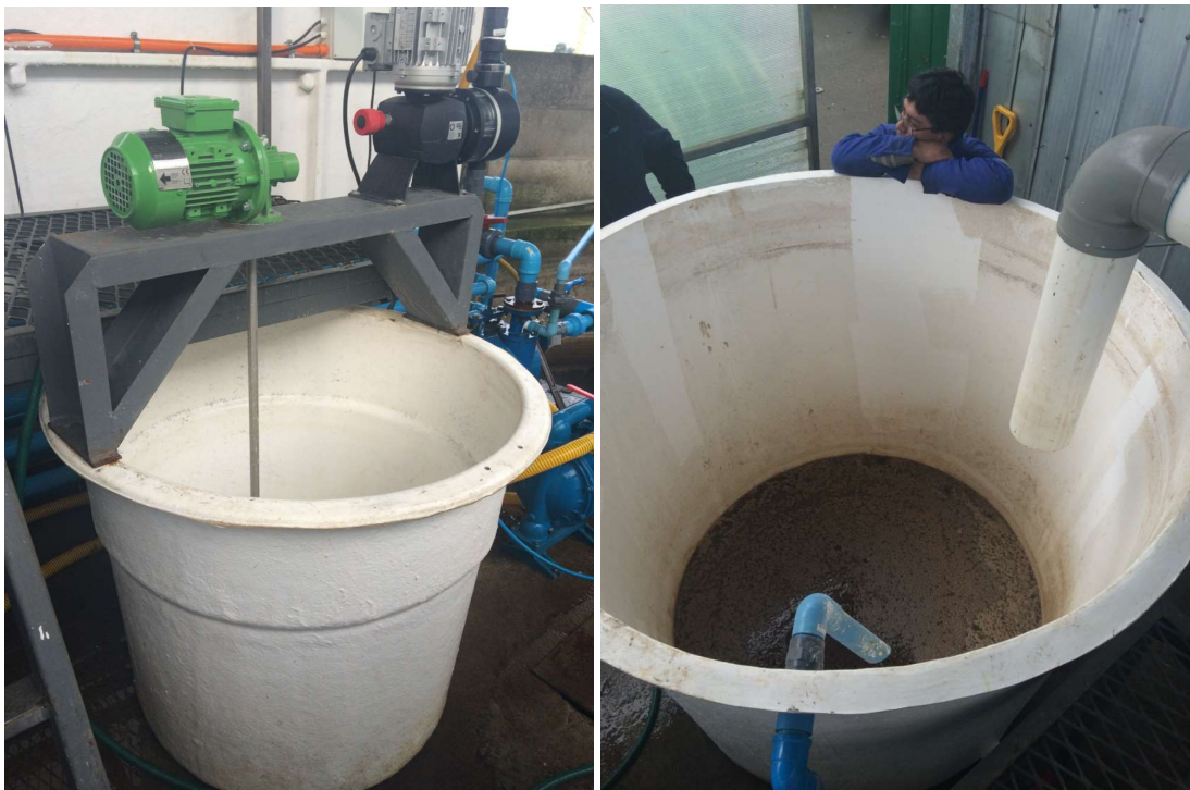
Figura 7. Estanque polímero y estanque lodos.
