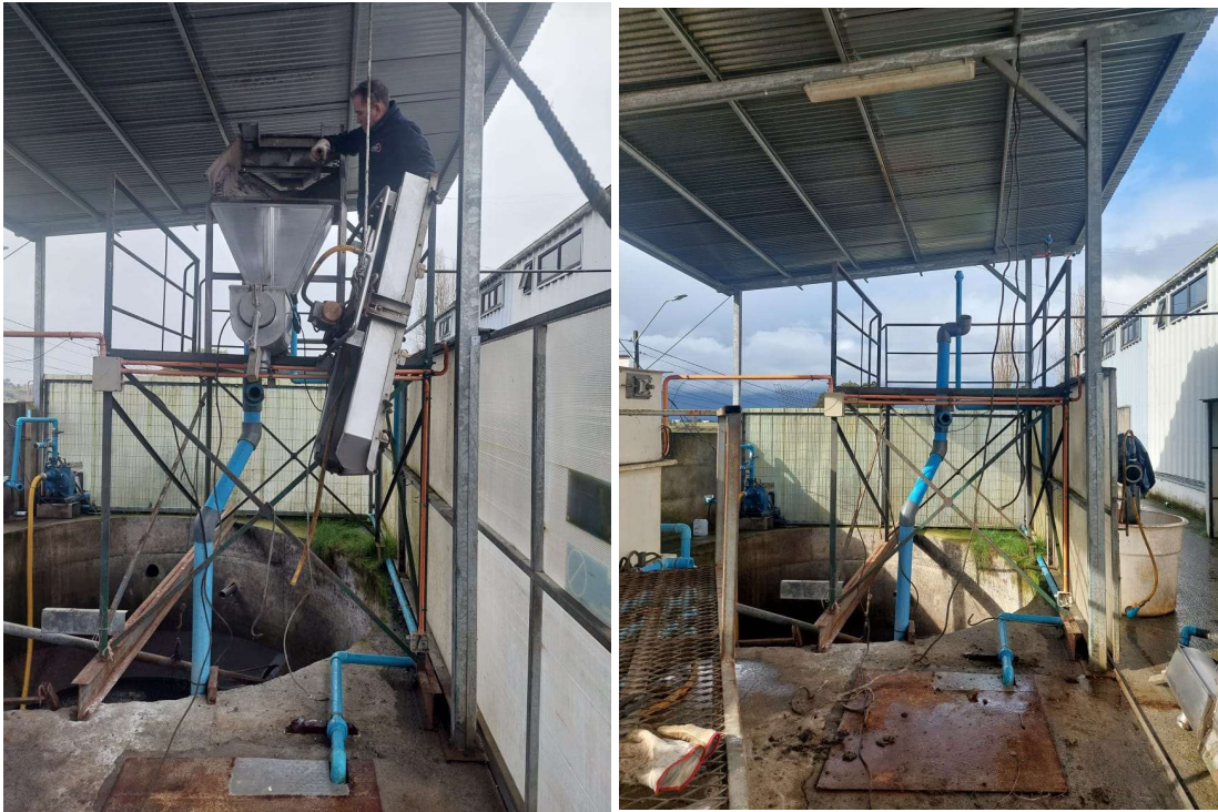
Figura 8. Desarme estructura filtro de sólidos.
