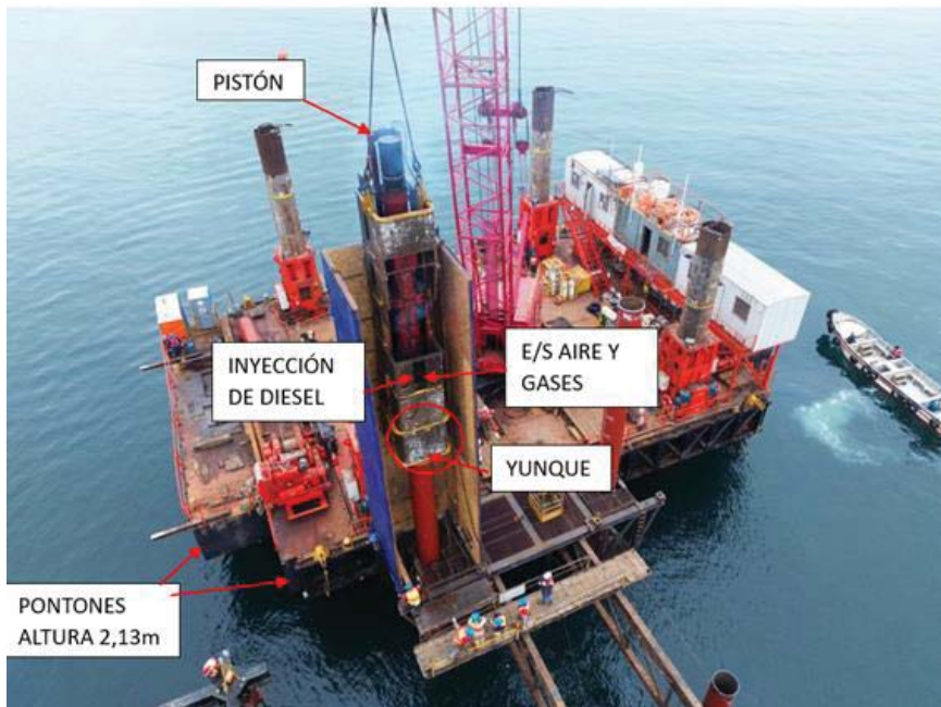
Imagen 3. Fotografía Frente "Jack Up" con indicación de estructuras. (Fuente: Registro propio).
