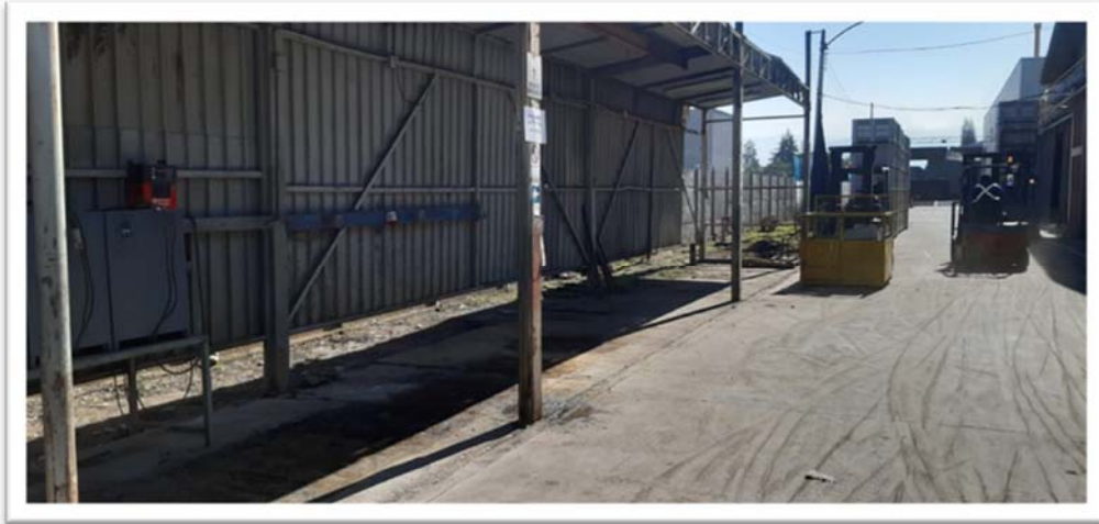
Imagen 4. Galpón de Baterías Después
