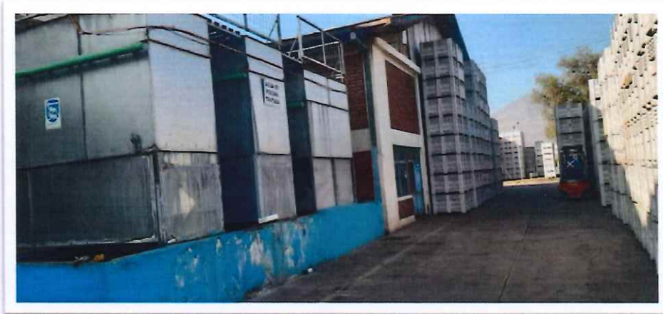
Imagen 11. Evidencia Columnas de Bins Después – Cierre Sala de Maquinas
