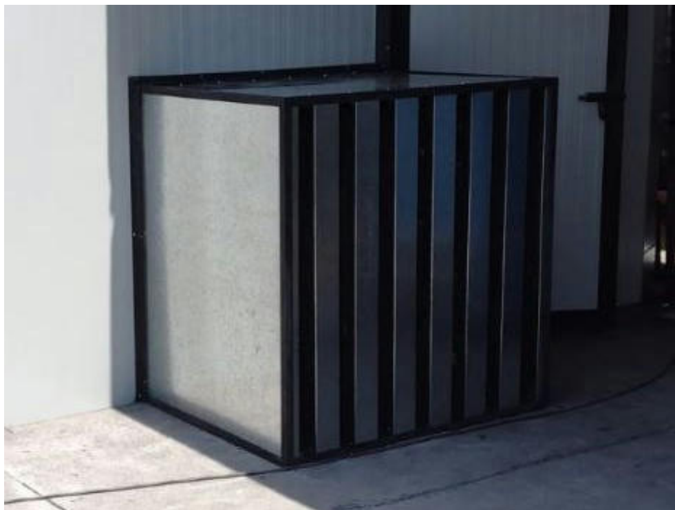
Figura 4: Fotografía de muestra de un silenciador de tipo Splitter a instalar en el local “La Antojería”.
