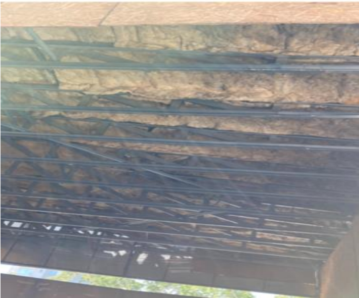
Aplicación de refuerzo de lana mineral a la techumbre para mitigar fuga de ruido por techumbre Del túnel acústico media realizada el 24 de Marzo 2023
