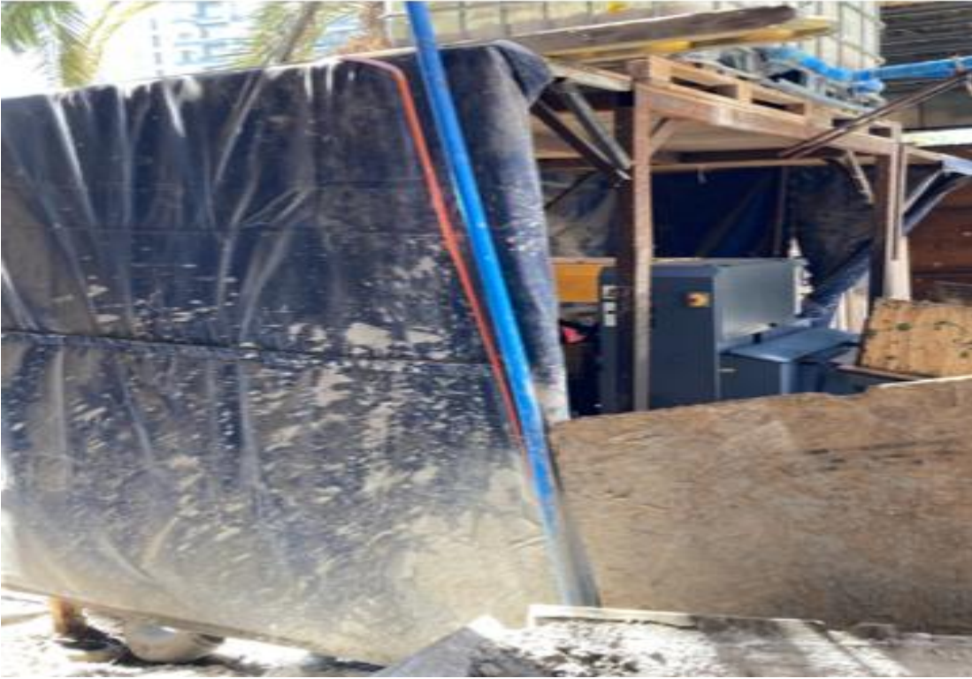
Instalación de tercera cara con manto acústico de la bomba de Hormigón instalada posterior a la fiscalización como reforzamiento a la medida de mitigación original.
