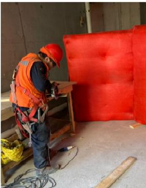
Biombos en zona de cortes de madera
