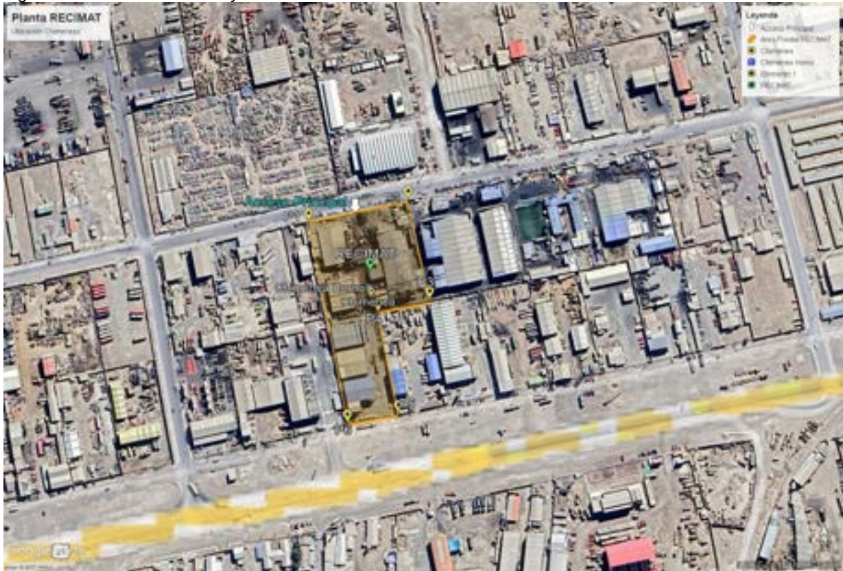
Figura 1. Ubicación RECIMAT y Chimeneas. Planta Calama.
