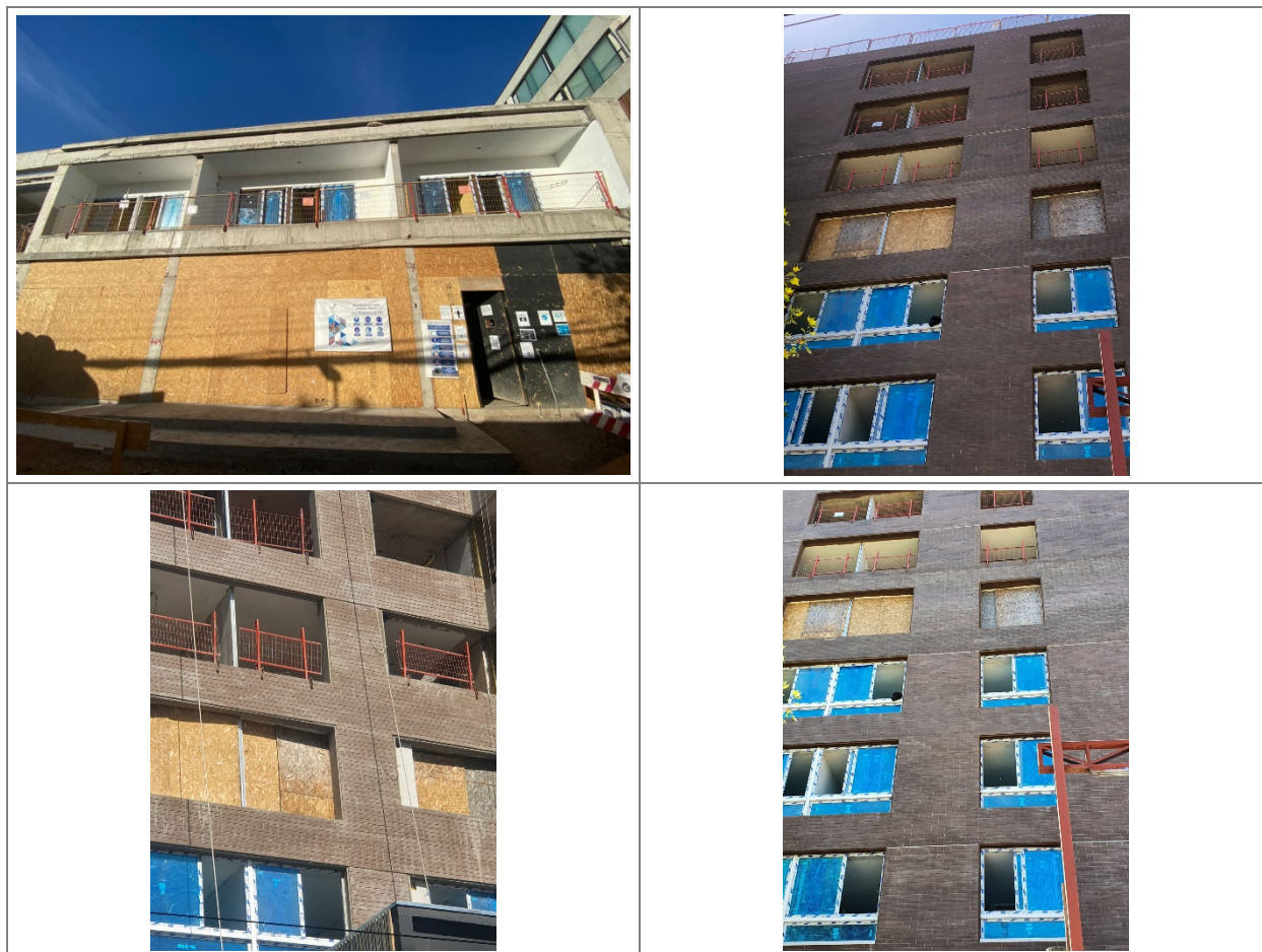
FIGURA 6. IMAGEN DE CIERRE DE VANOS CON PANELES DE OSB EN FAENA MANUEL MONTT 1204
