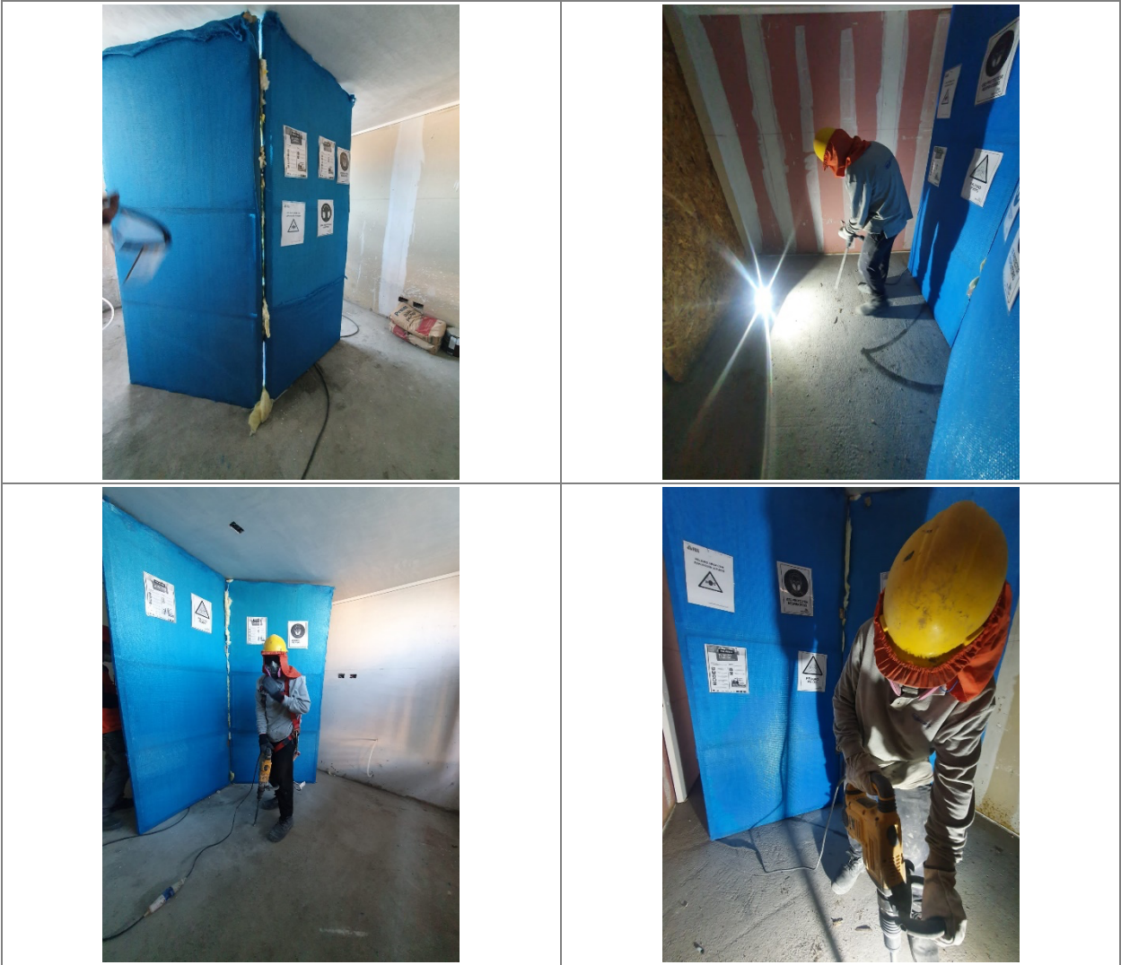
FIGURA 7. BIOMBOS ACÚSTICOS IMPLEMENTADOS EN FAENA MANUEL MONTT 1204.
