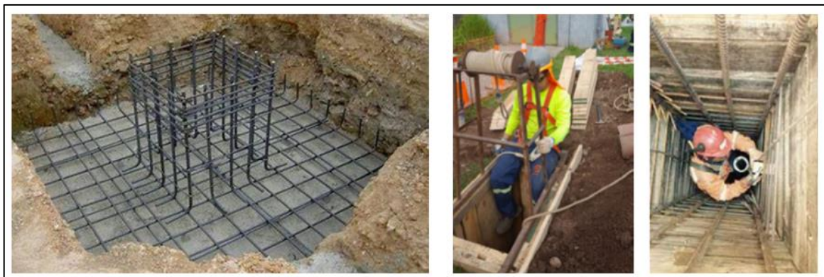
Figura 17. Fundación superficial (derecha) y pila (izquierda)
