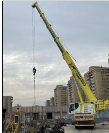
Figura 19. Camión grúa en TSE
