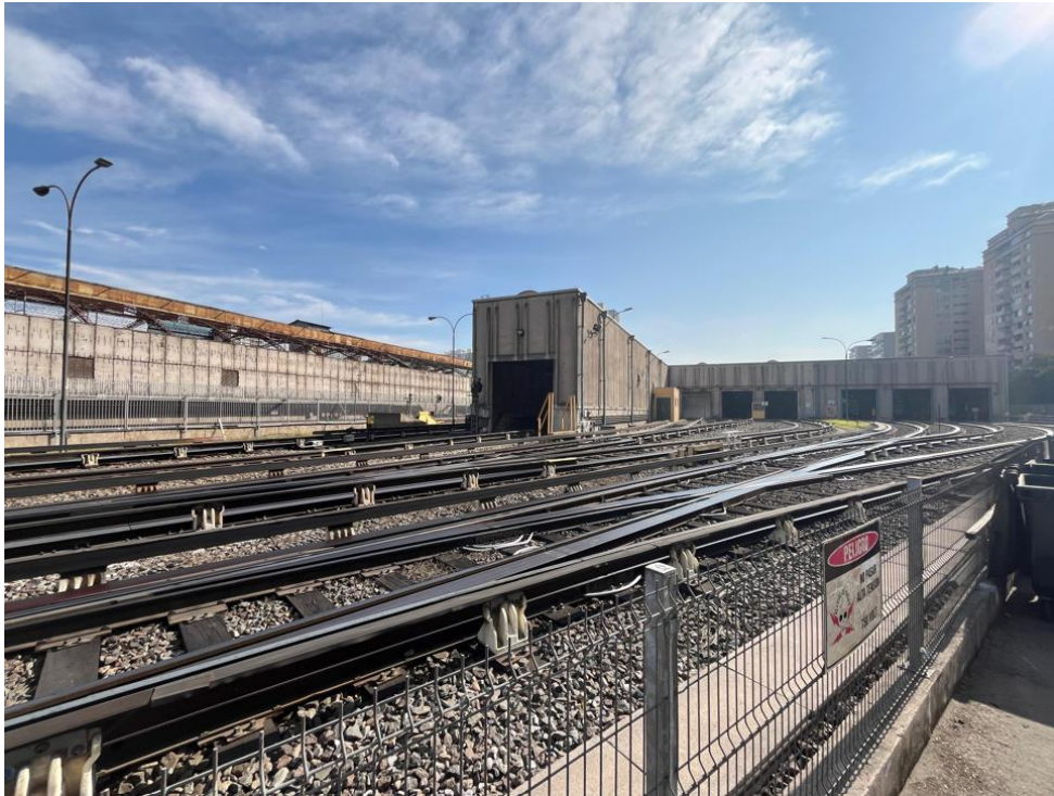
Figura 3. Haz de vías talleres
